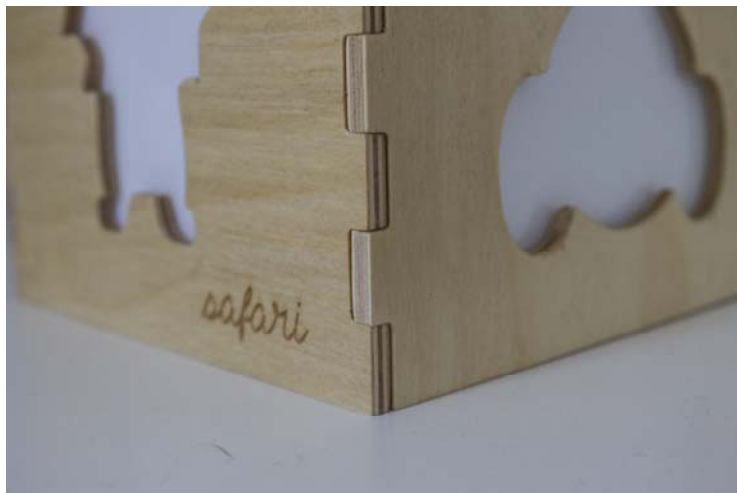
Obrázek 51: Fotografie ozubového spoje u světla (vlastní zdroj)
