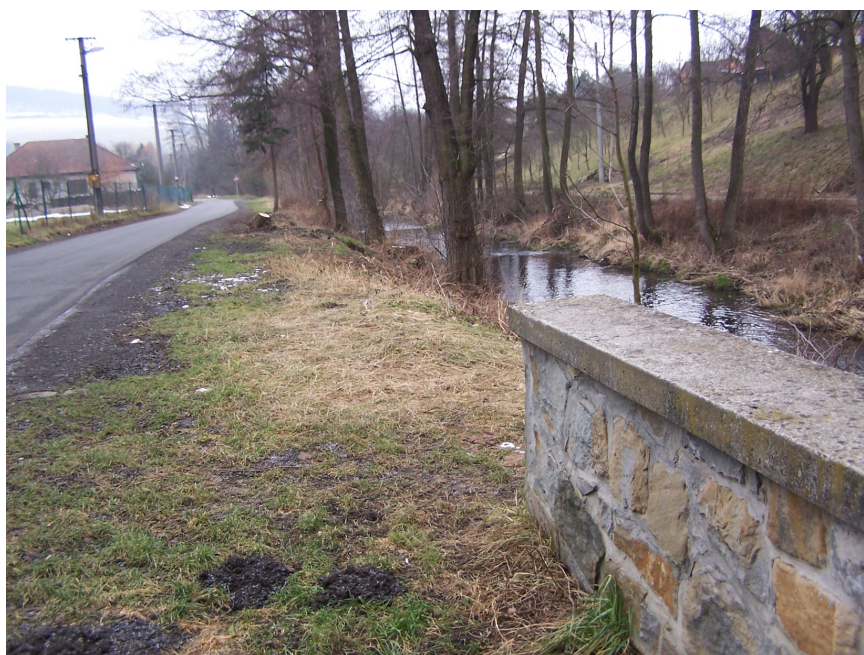
Obrázek 13: Km 0,865 konec protipovodňové stěny vybudované v 1. fázi výstavby [7]
