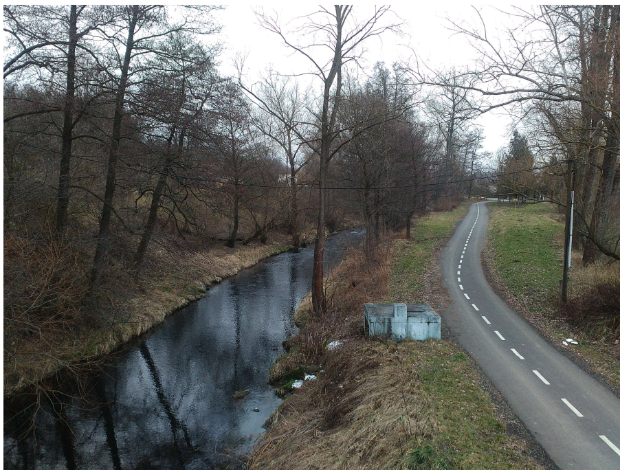
Obrázek 18: Km 0,274 pohled z železničního mostu proti proudu řeky Brumovky [7]
