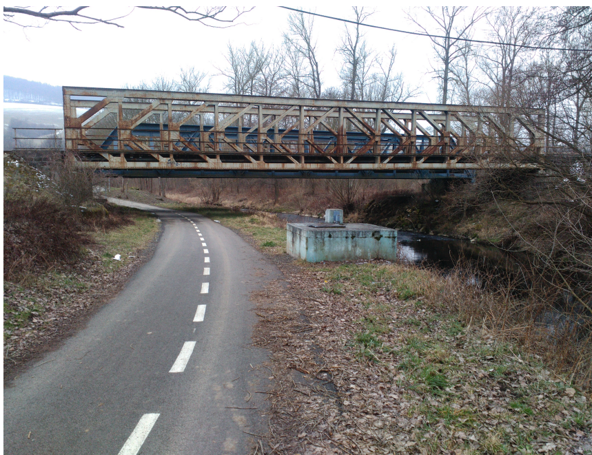
Obrázek 6: Km 0,278 železniční most [7]
