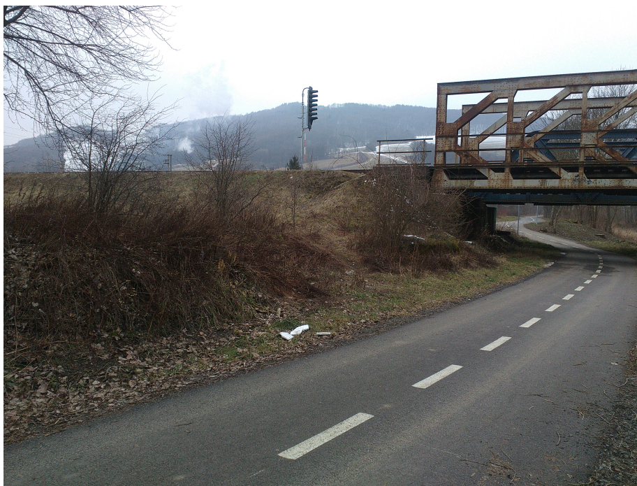
Obrázek 12: Km 0,276 napojení zemí hrázky na železniční násyp [7]
