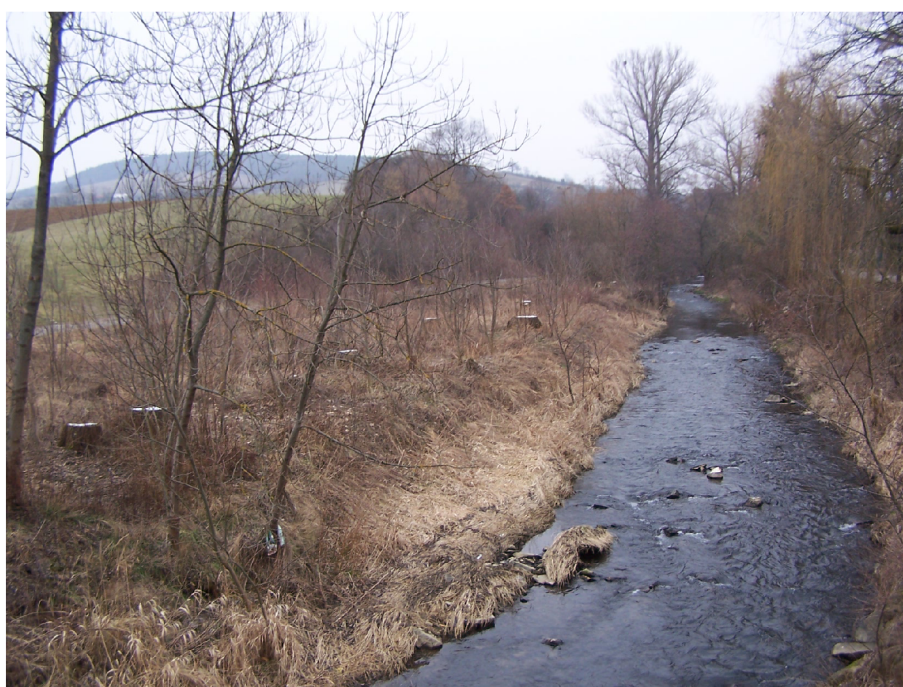
Obrázek 21: Km 0,465 pohled s pěší lávky proti proudu řeky [7]
