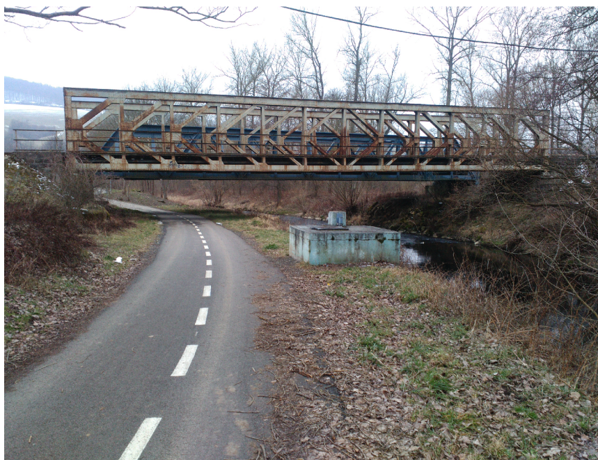
Obrázek 6: Km 0,278 železniční most [7]
