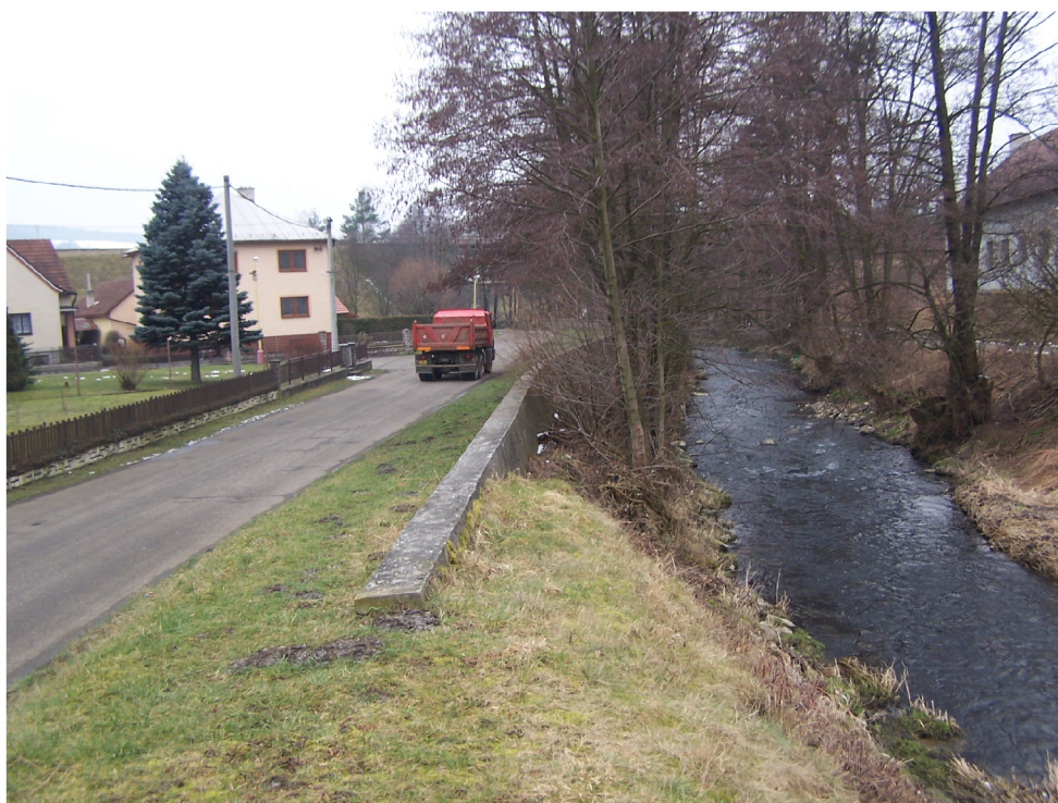
Obrázek 8: Napojení betonové stěny na sypanou hráz [7]
