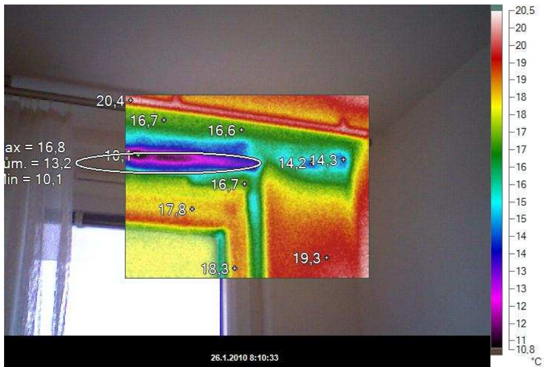
Obrázek 6.1 – 2b) - Tepelný most v místě překladu, rozdíl teplot 9,2°C [13]
