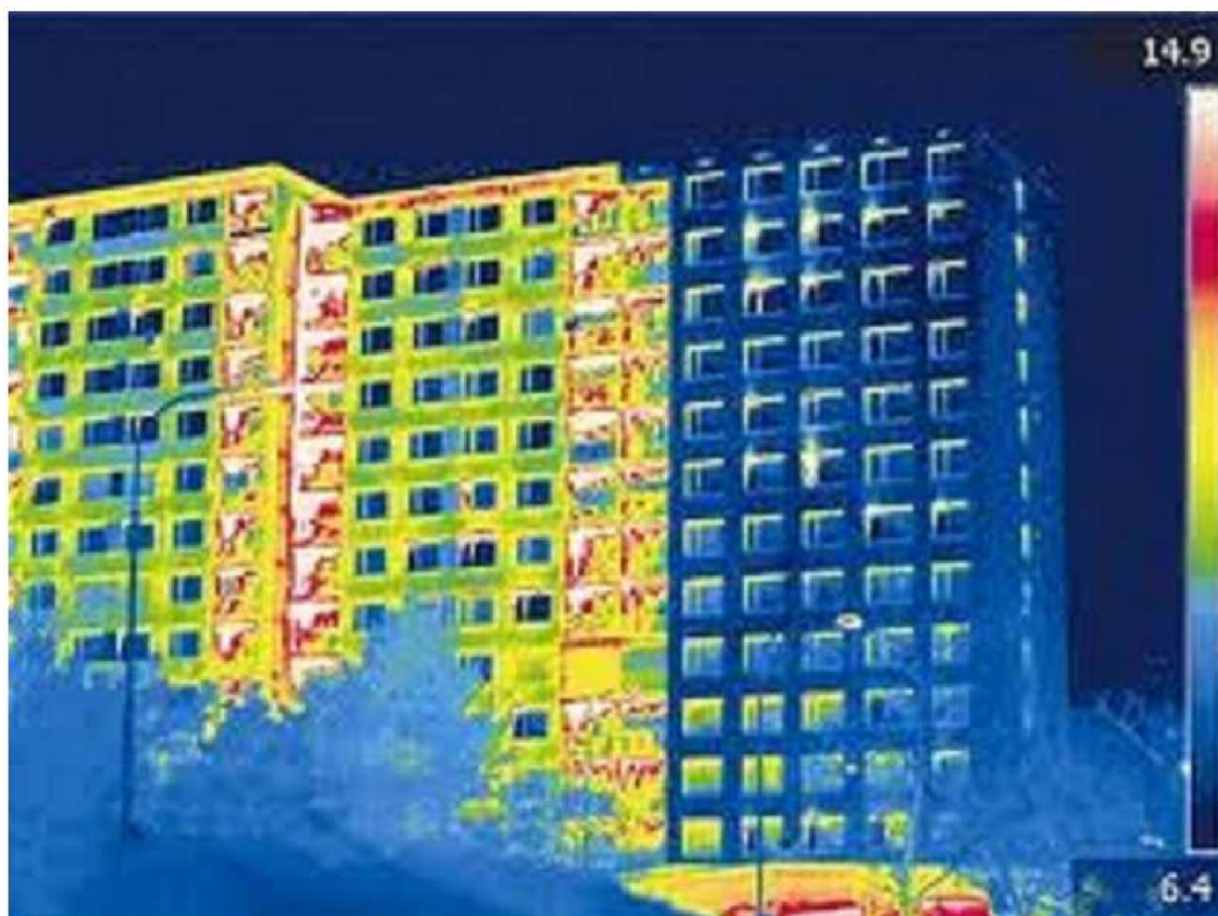
Obrázek 6 – 2 – Úniky tepla u částečně zatepleného domu – termovize [10]
