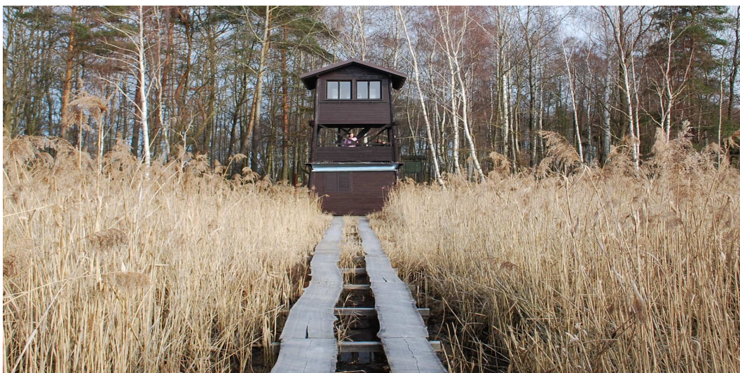
Obr. č. 5: Pozorovací věž
