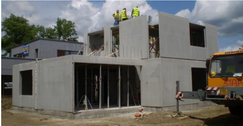
Obrázok 23 - RD s prefabrikovanou betónovou konštrukciou [28]
