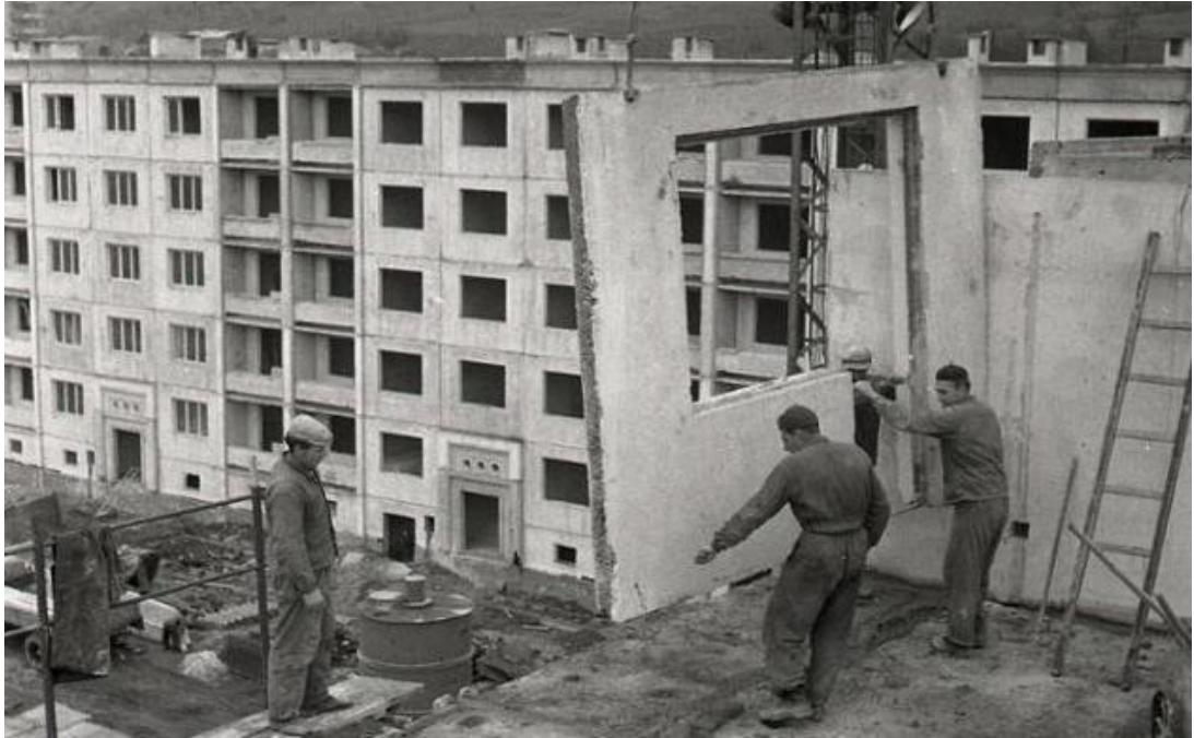
Obrázok 8 - Výstavba panelového domu [10]
