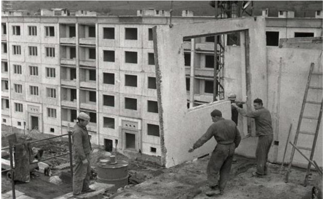
Obrázok 8 - Výstavba panelového domu [10]
