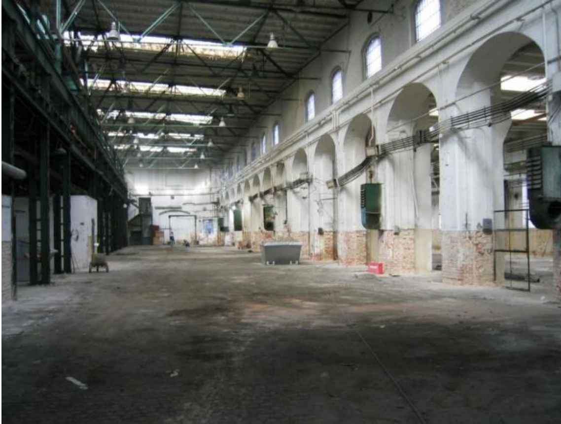
Obr.1 Areál továrny před rekonstrukcí (Obchodní centrum....., 2017)
