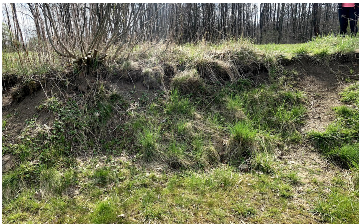
Obrázek 15 – Abrazní srub úseku B [20]
