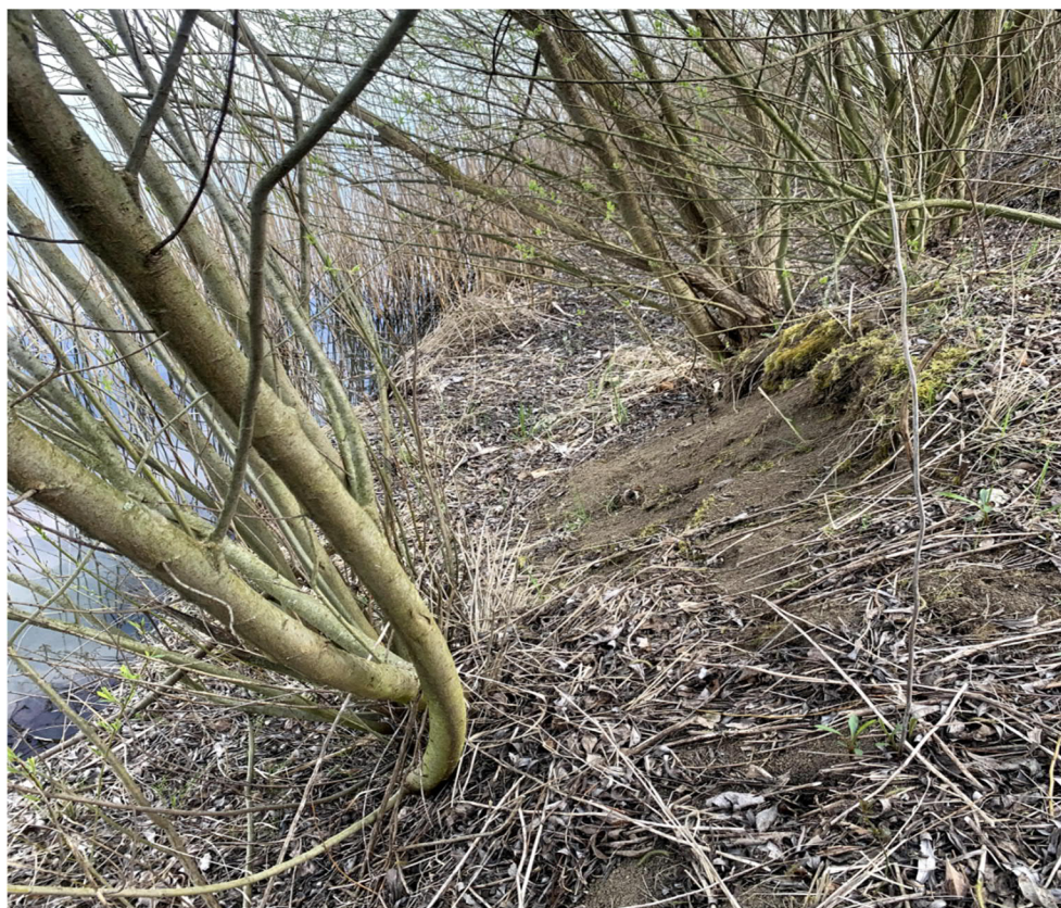
Obrázek 13 – Abrázní srub v úseku A [20]
