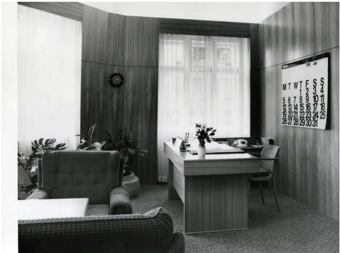
Obr. 144 Kancelář ředitele nábytkářského průmyslu, Brno, roh Zelného trhu
