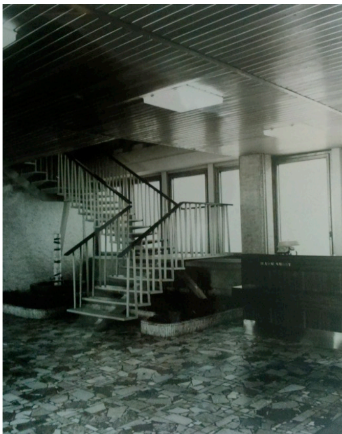
Obr. 157 Interiér administrativní budovy, pravděpodobně 70. léta
