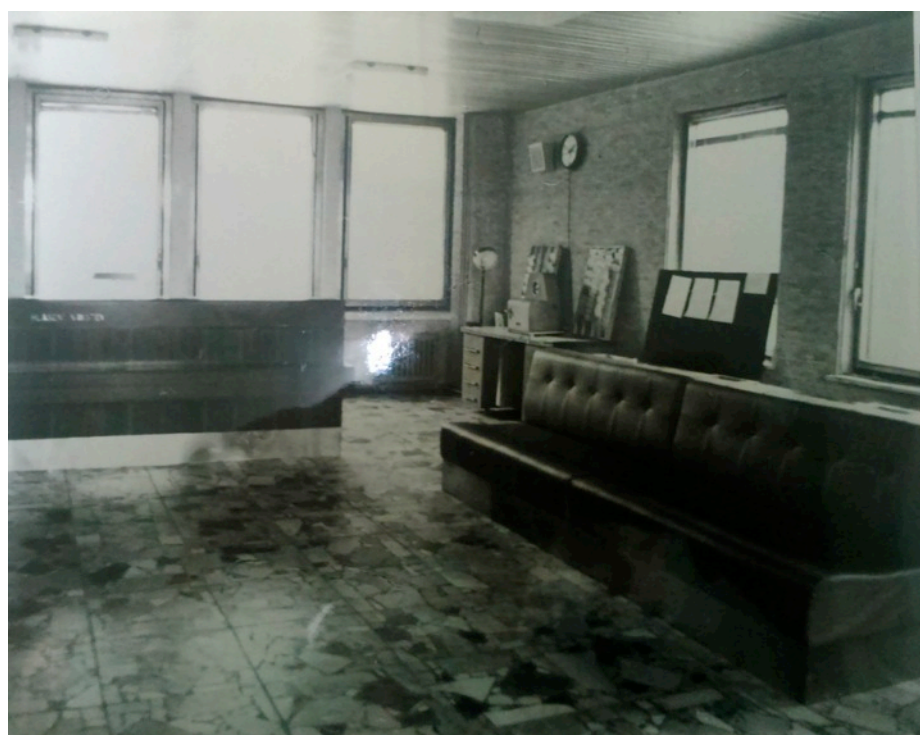
Obr. 156 Interiér administrativní budovy, pravděpodobně 70. léta
