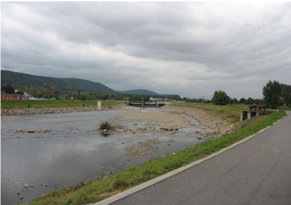
Obr. 36 Pohledy na jezy v Hranicích 2011 [32]
