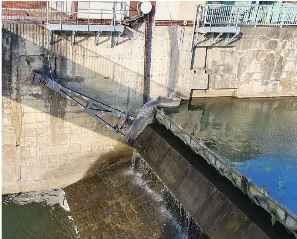
Obr. 40 Segmentový uzávěr s dutou klapkou, Hranice [33]
