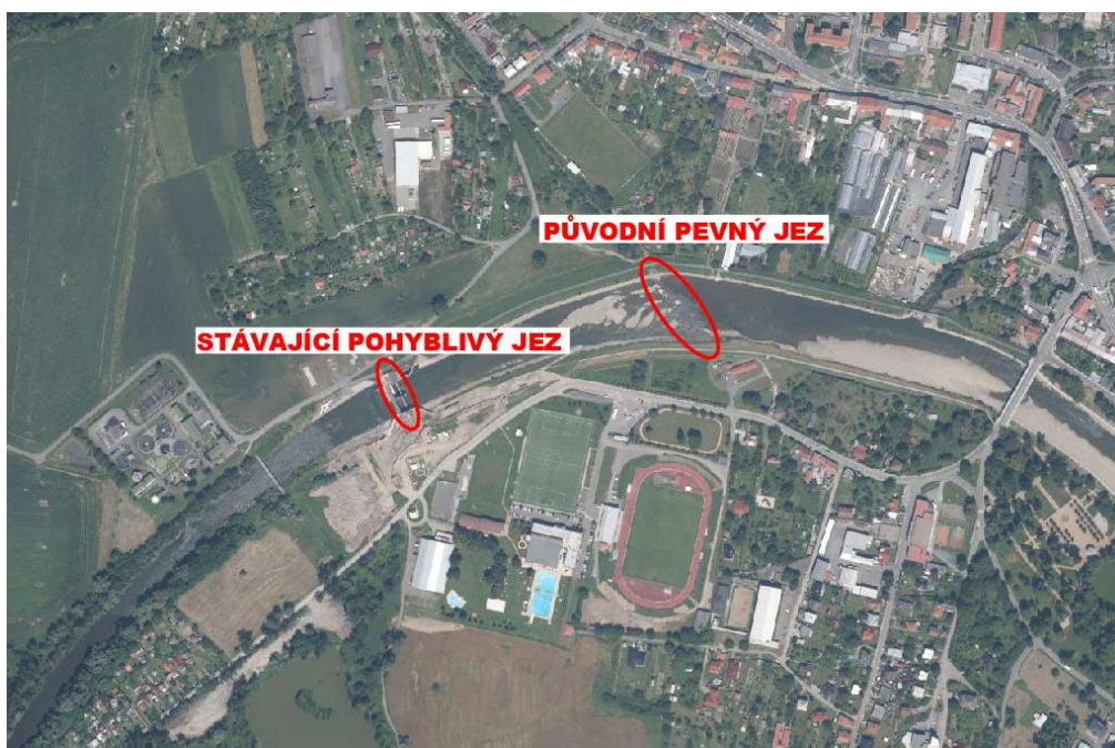
Obr. 30 Umístění původního pevného jezu v Hranicích [34]
