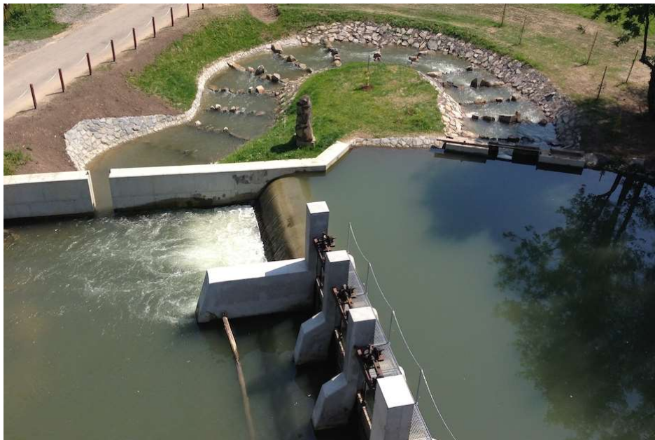
Obr. 9 Rybí přechod (bypass) Loučná, mlýn Sárovec [14]
