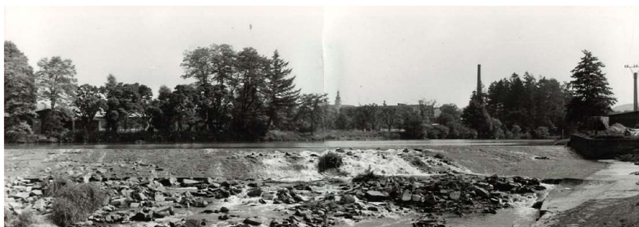
Obr. 32 Pohled na původní pevný jez z podjezí směrem k centru města 1982 [32]
