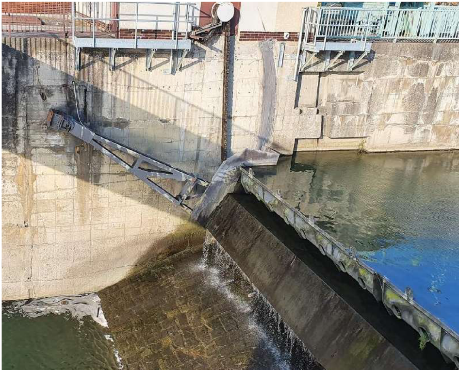
Obr. 40 Segmentový uzávěr s dutou klapkou, Hranice [33]
