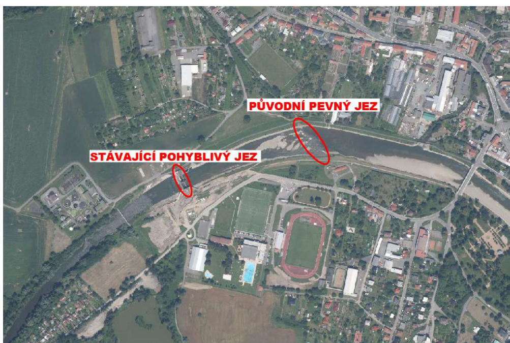
Obr. 30 Umístění původního pevného jezu v Hranicích [34]
