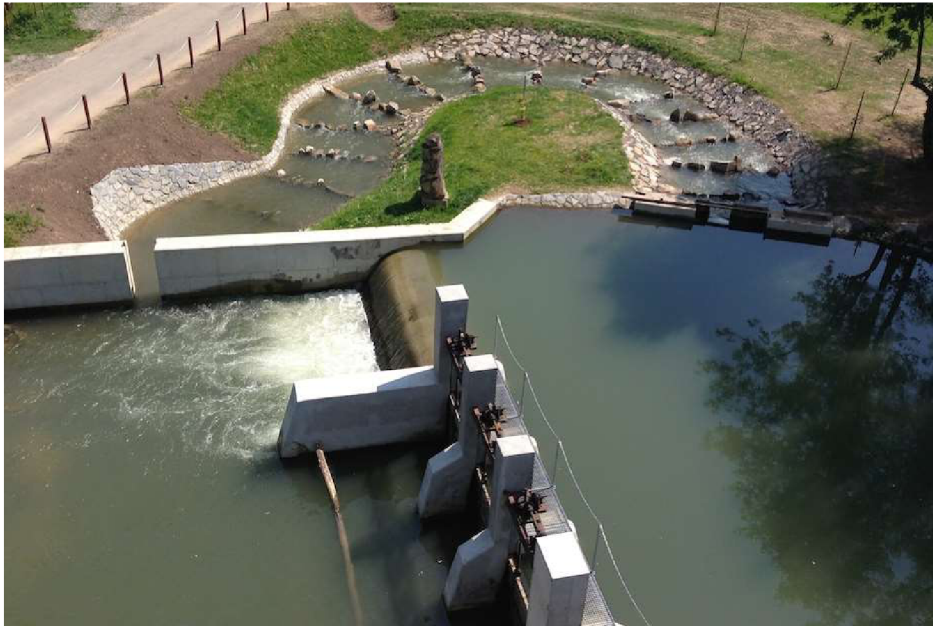
Obr. 9 Rybí přechod (bypass) Loučná, mlýn Sárovec [14]
