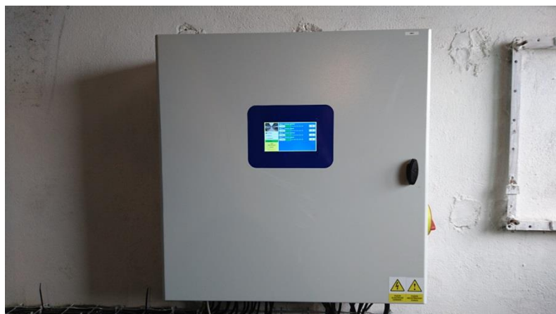
Příloha A - centrální rozvaděč pro řízení stáje
