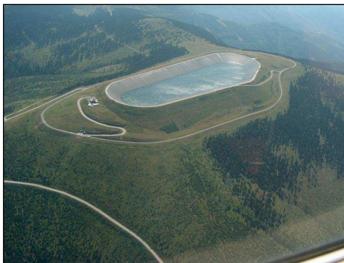
Obr 0.2 Horní nádrž vodní přečerpávací elektrárny Dlouhé Stráně [10]
