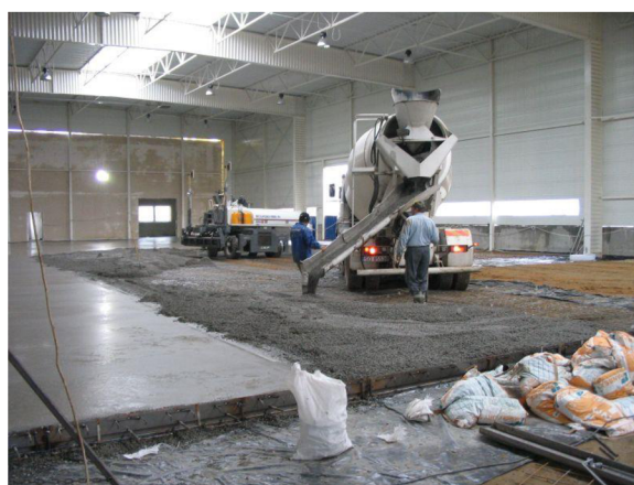
Obrázek 2 Podlaha z betonu s rozptýlenou ocelovou výztuží v průmyslové hale [5]
