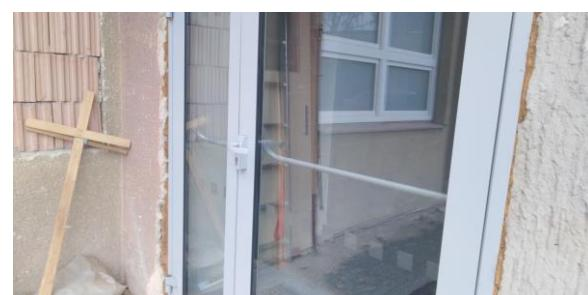
Perimetru je tvořen z hlavní části pláštěm budovy. Plášť budovy tvoří železobetonový monolit, 2. NP je tvořeno ocelovou konstrukcí, opláštěnou PUR deskami. Hlavní vstup tvoří kovové dvoukřídlové dveře s velkoplošnými prosklenými plochami. Plášť je dále tvořen plastovými okny a plastovými prosklenými dveřmi nouzových východů, viz obr. vpravo.
