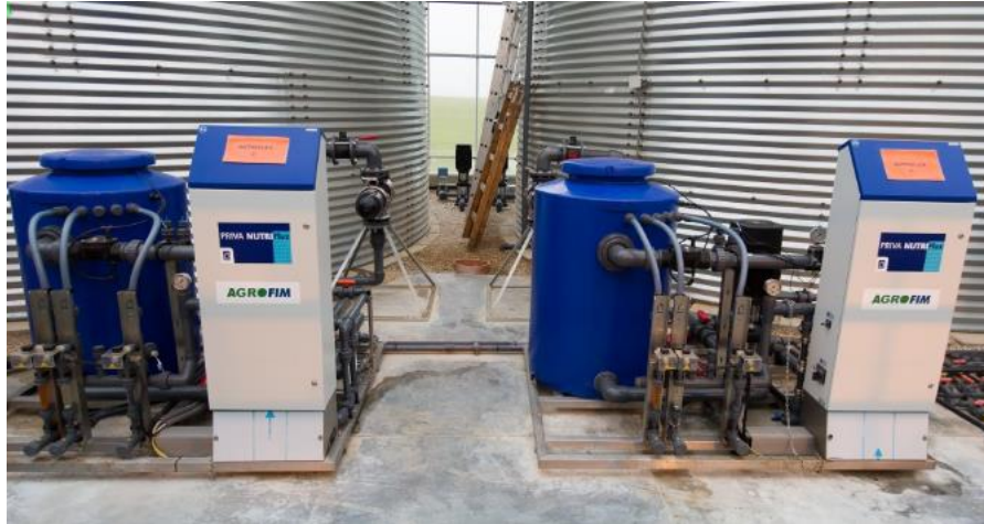
Obr. 2.13 Retundačné čerpadlo pre dopravu denného menu ku koreňom paradajok Zdroj: Vlastné spracovanie.
