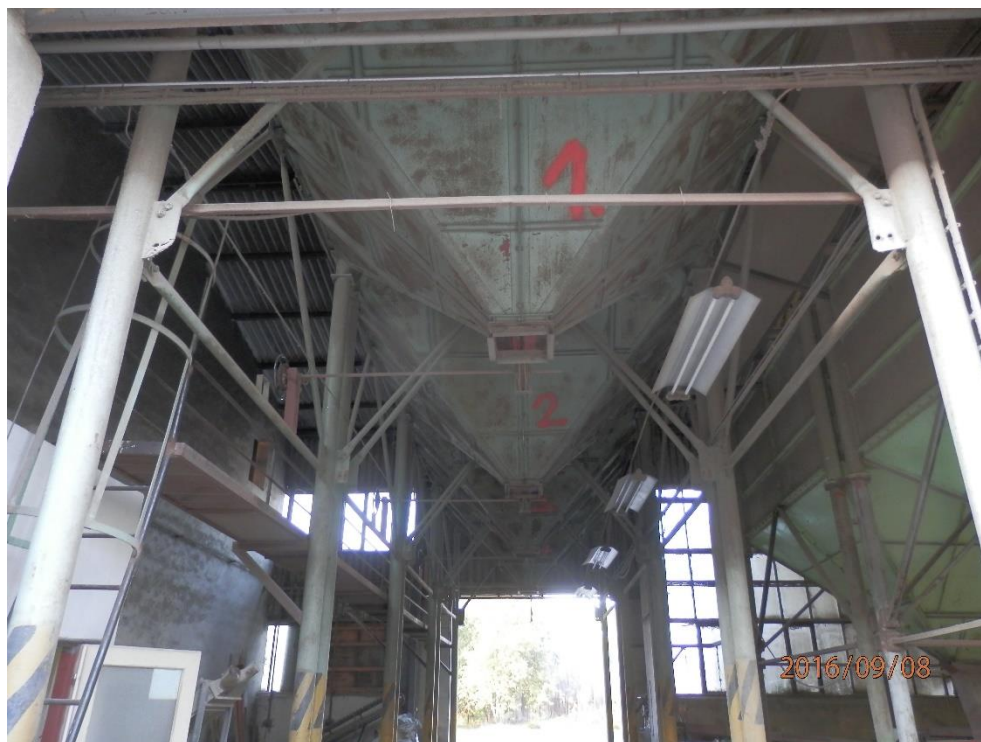
Obrázek č. 17 - Podjezdové zásobníky v ZD Březina nad Jizerou (Prokurát, 2016).
