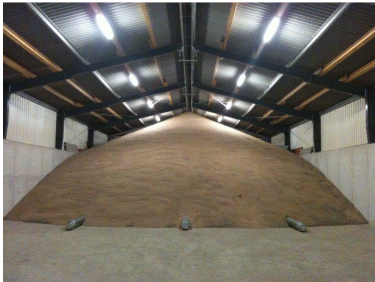
Obrázek č. 6 - Halový sklad obilí s nadúrovňovými kanály pro provzdušňování, zdroj: http://anafoodmachinery.all.biz/cs/teleskopicke-provzdušnovaci-potrubi-g833507 „staženo dne 27. 1. 2017“
