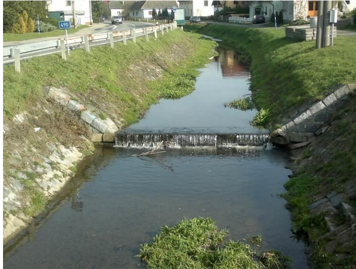
Obr. 7: Úprava koryta v Bohuslavicích u Zlína
