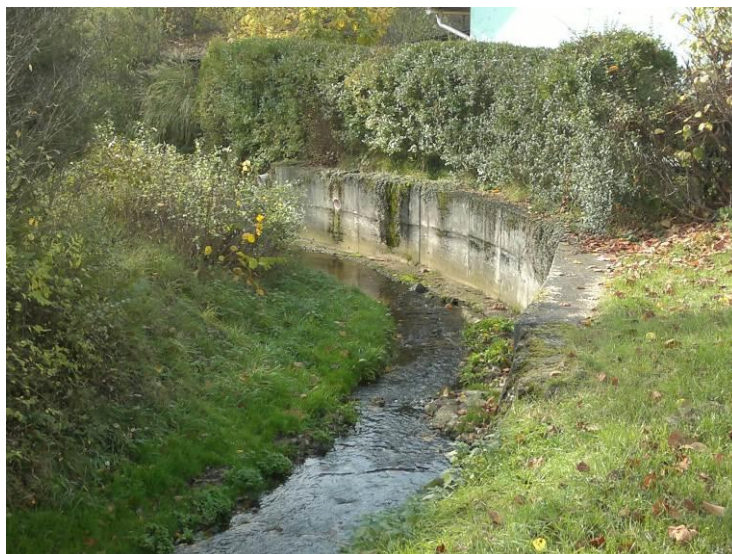
Obr. 3: Úprava koryta Březnice v Březnici
