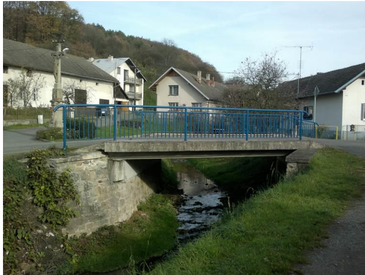
Obr. 1: Mostní konstrukce v Březnici
