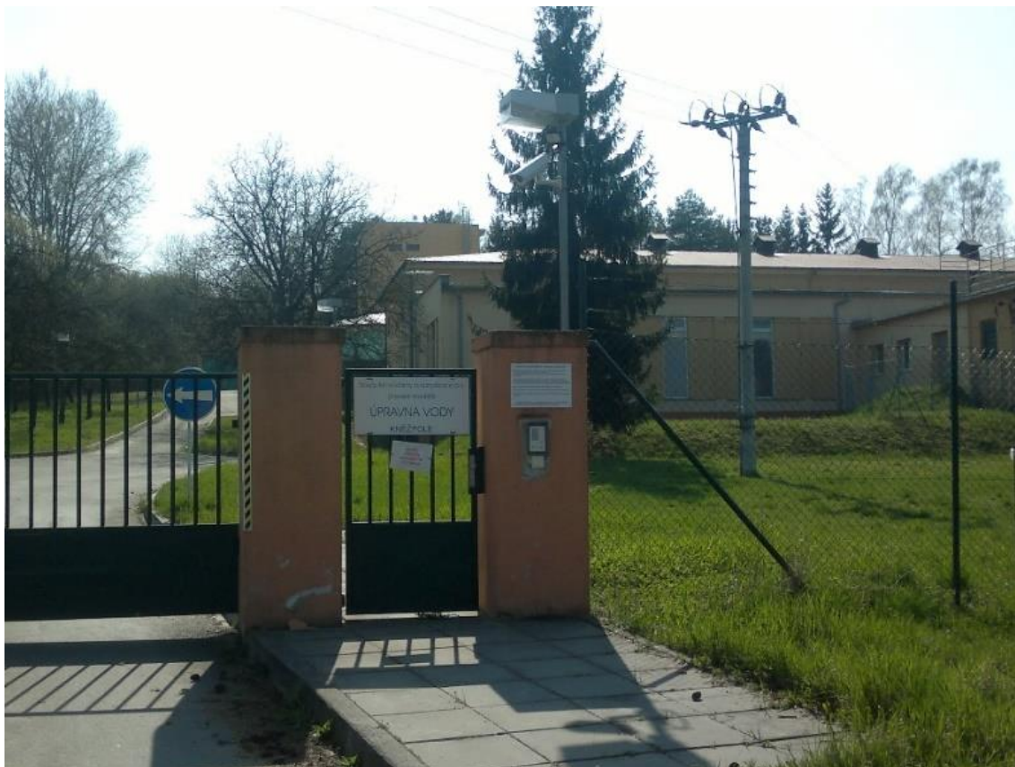
Obr. 5: Úpravna vody (foto: A. Cigošová, 2014)
