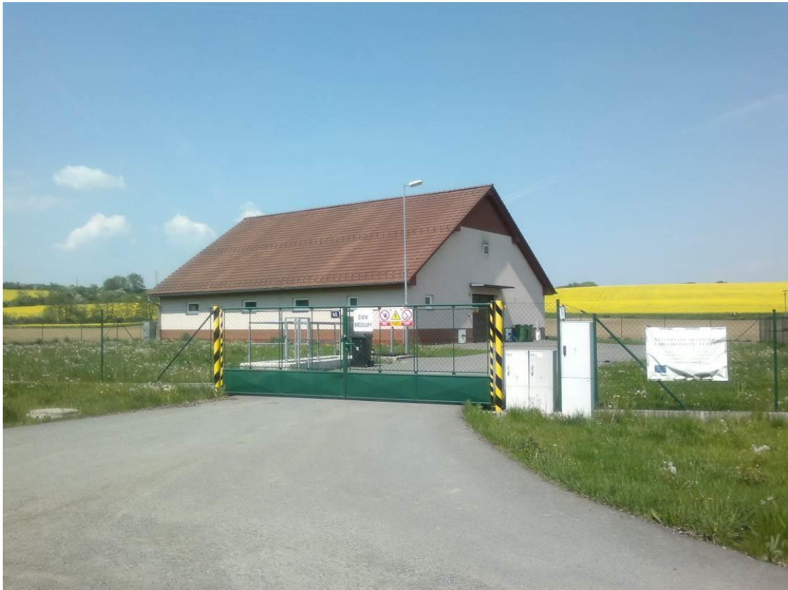
Obr. 11: Čistírna odpadních vod Březolupy (foto: A. Cigošová, 2014)
