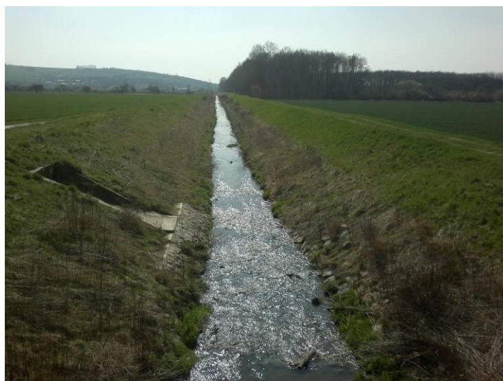
Obr. 16: Úprava koryta, ochranné hráze v Kněžpoli
