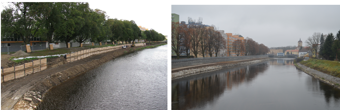
Foto 14 a, b Protipovodňová opatření na Otavě u soutoku s Volyňkou (Zdroj: [39] )
