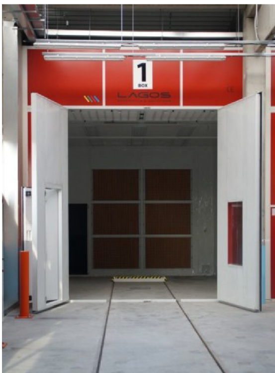
Obr. 3.7 Lakovací kabina syntetického nátěru LAGOS
