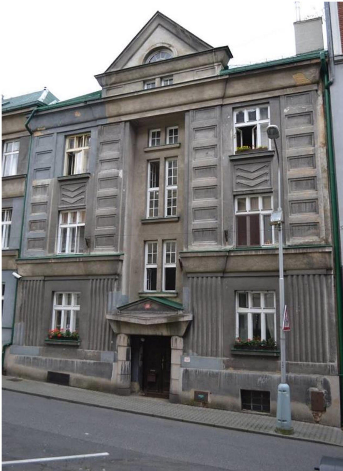
[15] Ludvík Juroš, Obytný dvojdóm na ulici Jiráskově ulici ve Frýdku, 1923–1924, pohled od jihozápadu.
