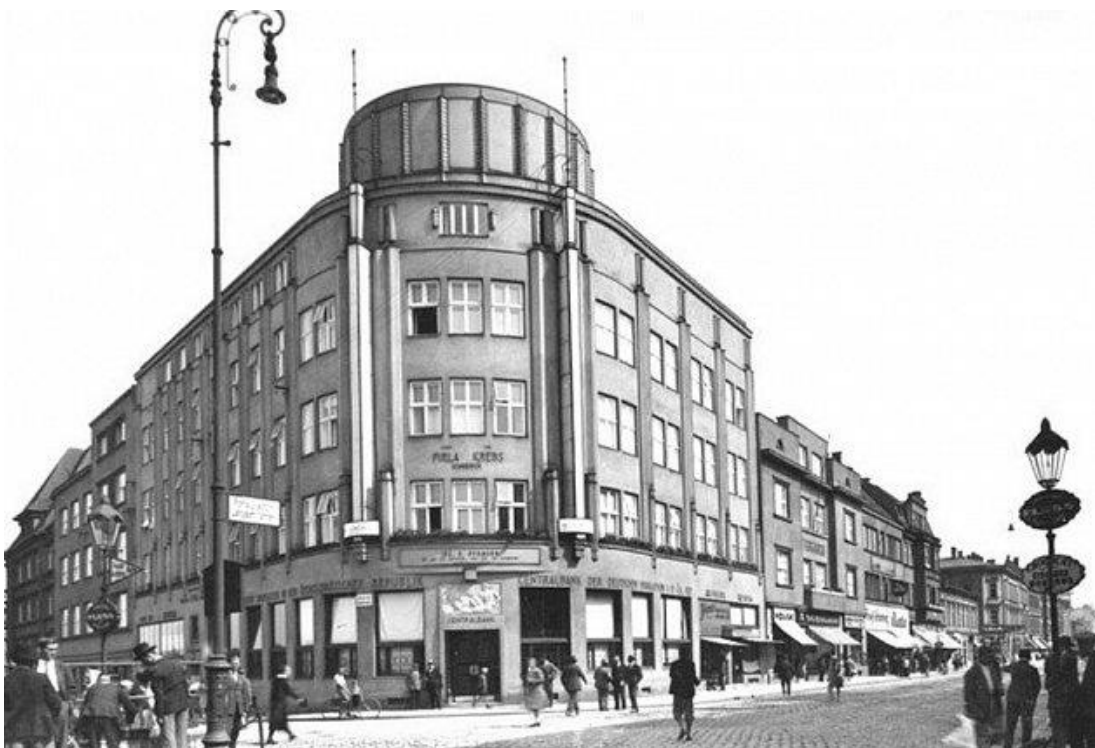
[12] Eugen Friedrich Fulda, Bankovní budova v Českém Těšíně, 1929–1930, pohled od jihozápadu.
