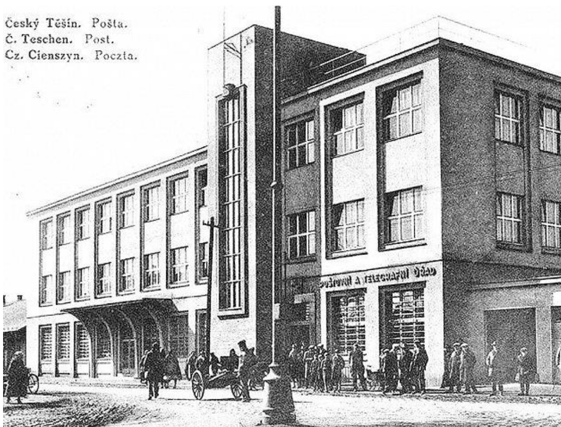
[9] Josef Zadražil, Poštovní a telegrafní úřad v Českém Těšíně, 1931, pohled od východu.
