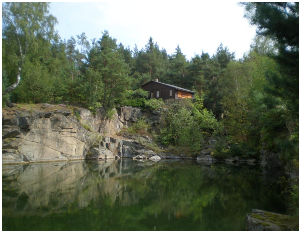
Obr č. 6: Rekreční chata z 60. let (architektonická jednotata), ST26H2 Roviště – u lomu
