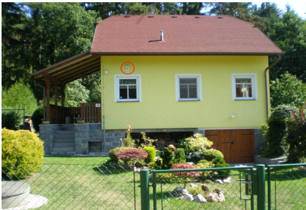
Obr. č. 21 : Zabezpečovací zařízení na rekreačním domku ST26I1 Na Břehách
