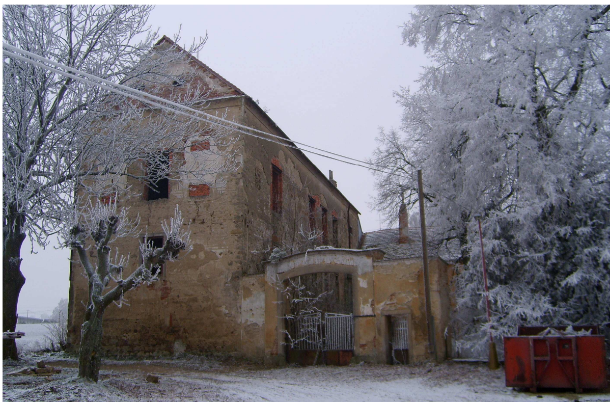
Obr. 4: Kostelní Vydří: Současný stav tvrze Koňasů z Vydří.
