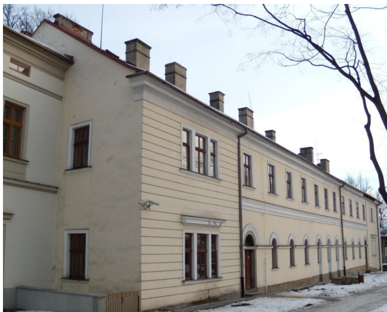
64. Josef Kornhäusel, Palác arcivévody Karla, 1838-1840, průčelí do parku, Těšín.
