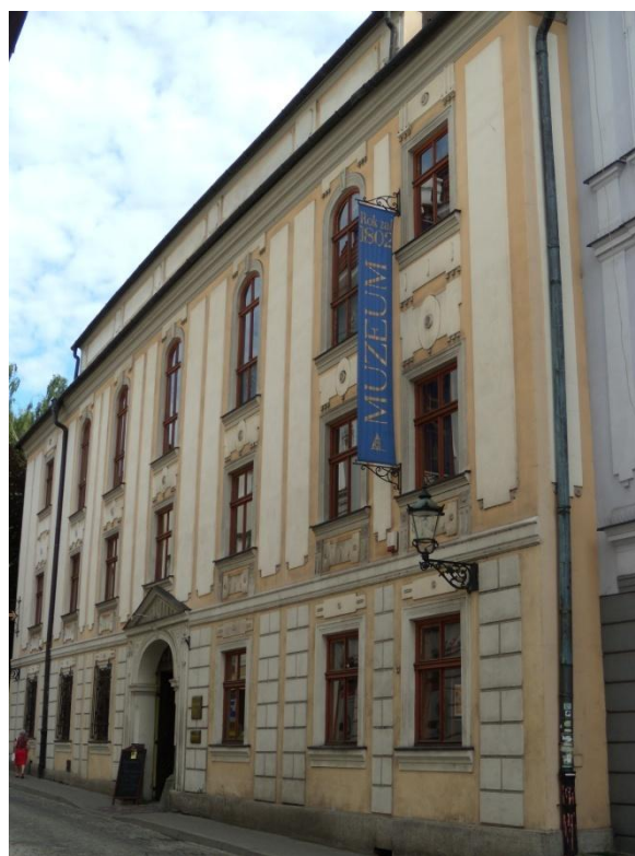
57. Těšín, Larischův palác, 1796, průčelí.
