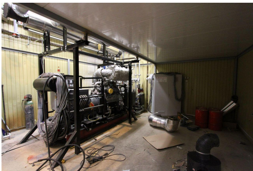
Obrázek 3.3 Průběh montážních prací a instalace kogenerační jednotky na rostlinný olej
