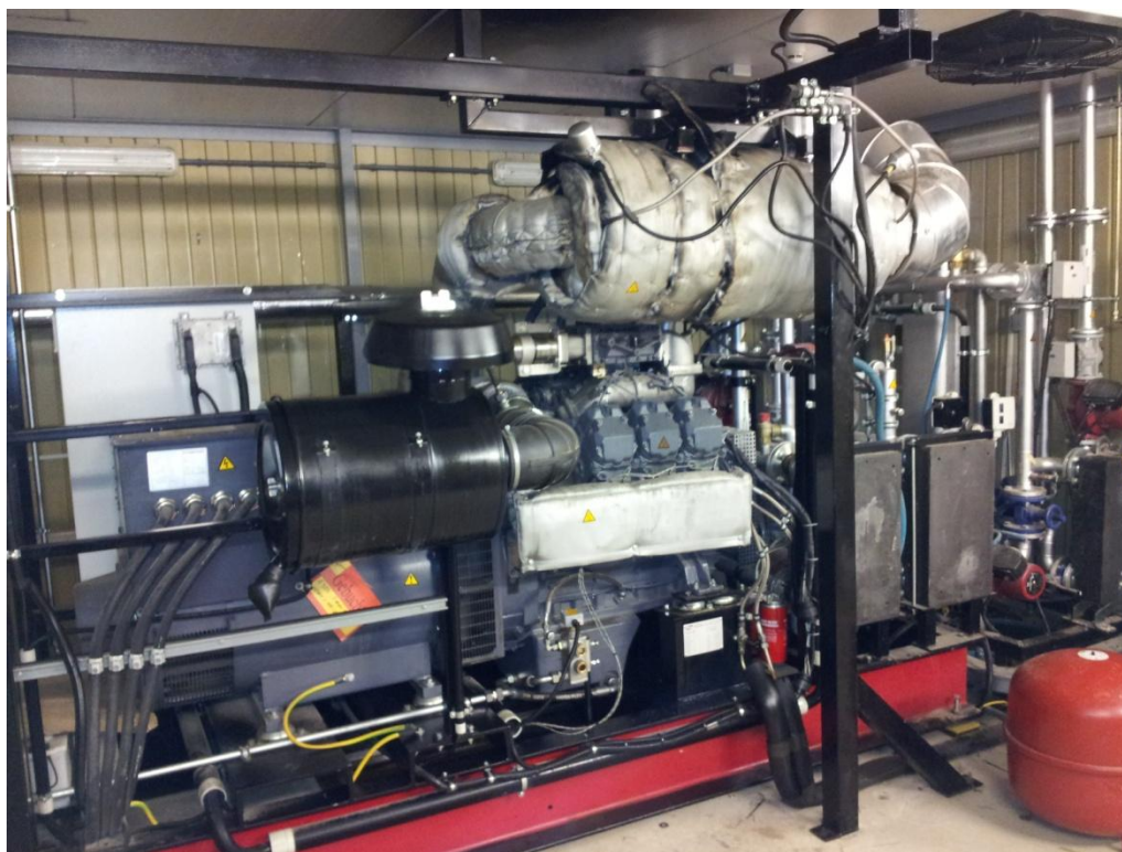
Obrázek 2.10 Kogenerační jednotka na rostlinný olej společnosti Seva Energie AG
