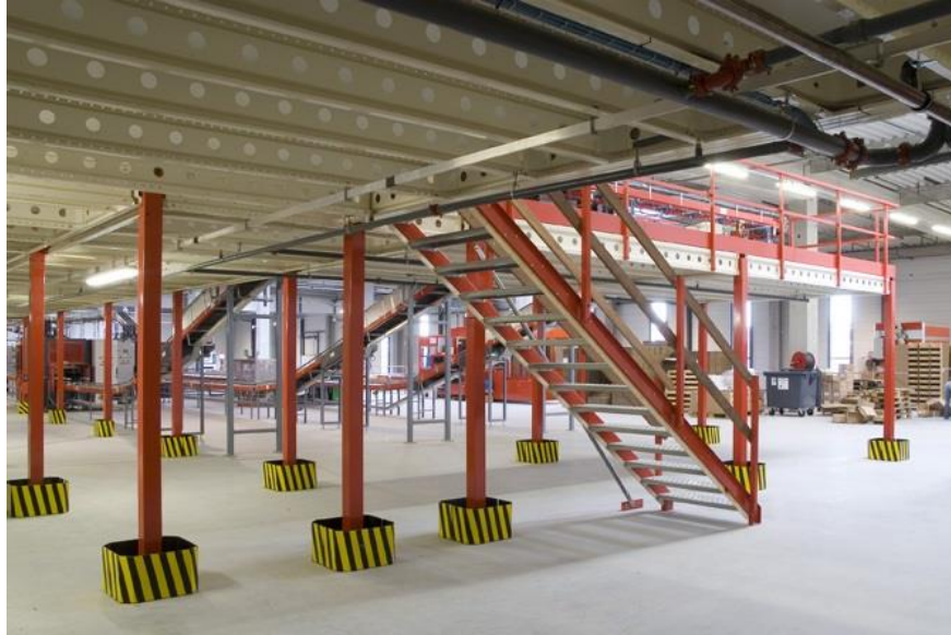
Obr. 1.4 Ukázka realizovaného vestavného podlaží
