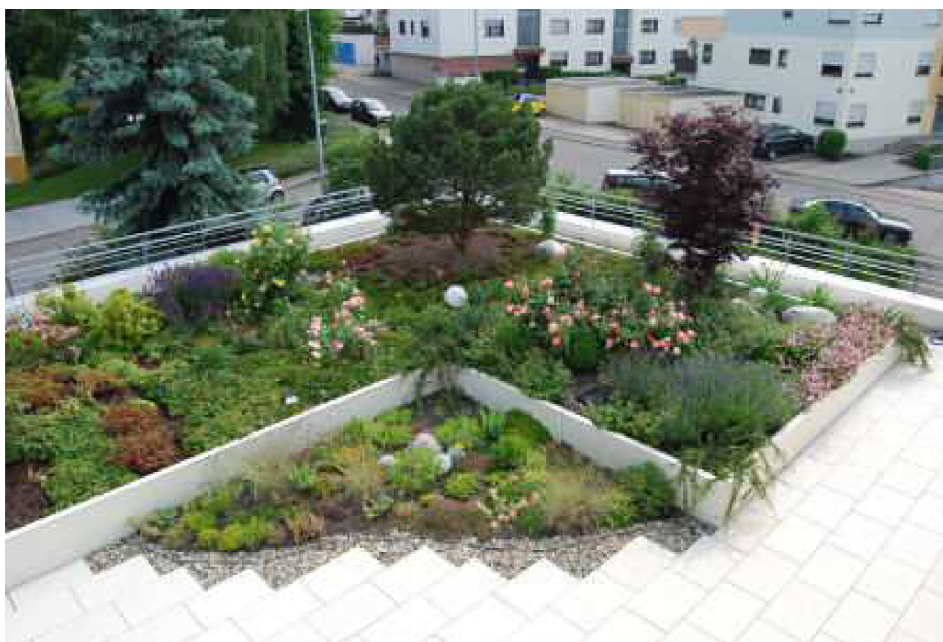
Obr. 8) Intenzivní zelená střecha – střešní zahrada
