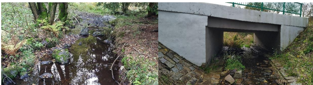
Obr. 76-77: Pohled na přírodní koryto toku a most pod vozovkou
