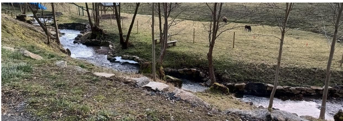
Obr. 51: Opevnění skládaným lomovým kamenem v Dlouhé Lomnici
