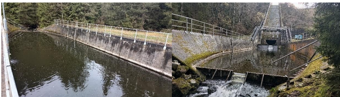
Obr. 28-29: Vývar vodního díla s Ponceletovým přelivem
