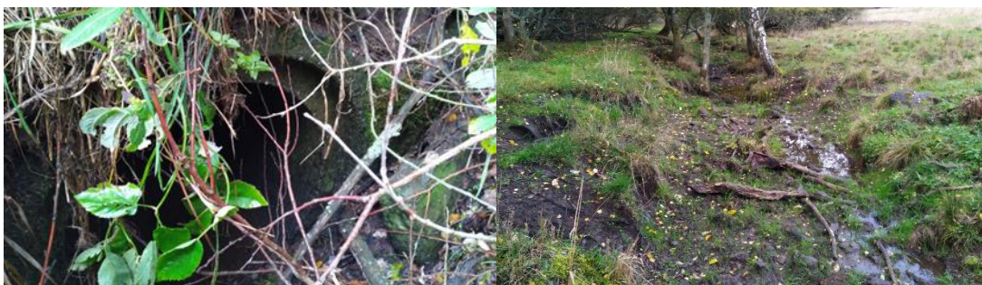
Obr. 84-85: Propustek pod lesní cestou a přírodní stav koryta
