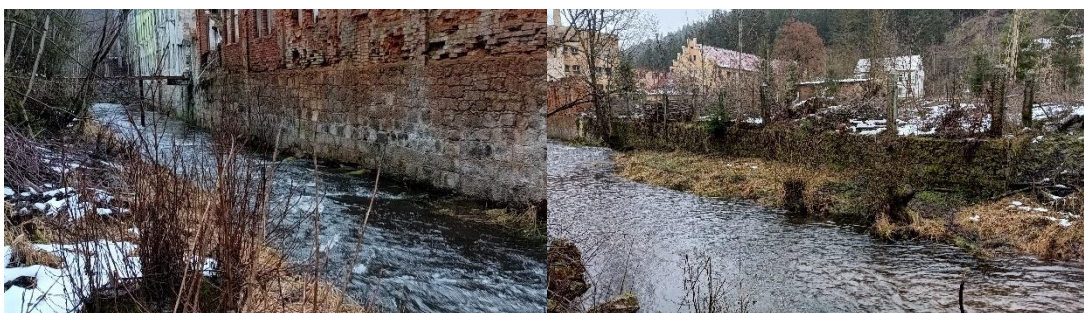
Obr. 17-18: Břehové opevnění v hodnoceném úseku
