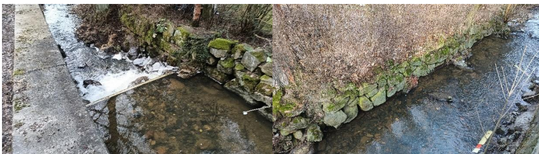
Obr. 58-59: Zhloubení koryta a břehové opevnění v Horních Tašovicích
