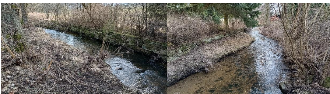
Obr. 47-48: Břehové opevnění v obci Dlouhá Lomnice
