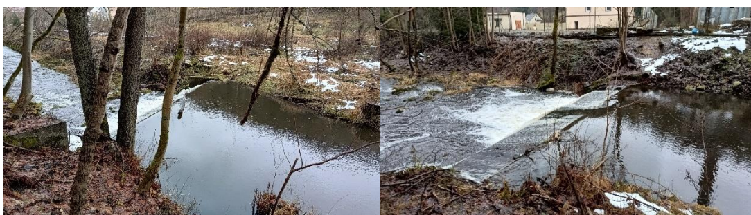
Obr. 15-16: Pohled na jezy ve sledovaném úseku
