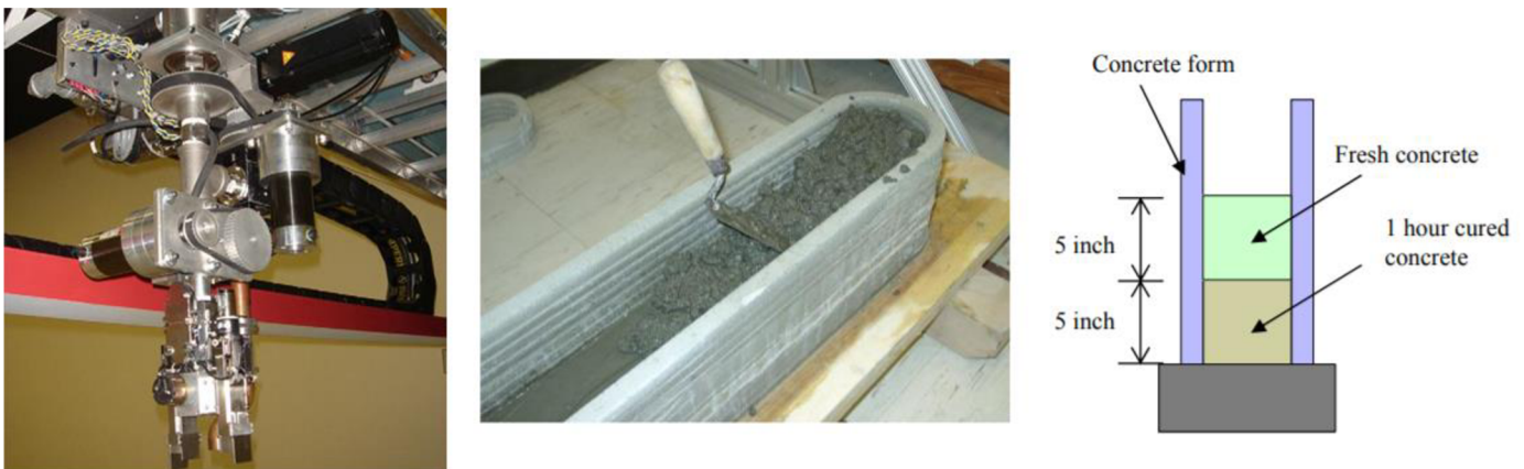
Obr 3-3 Tisková hlava metody CC (vlevo), plnění stěny betonem (vpravo). [12][13]
