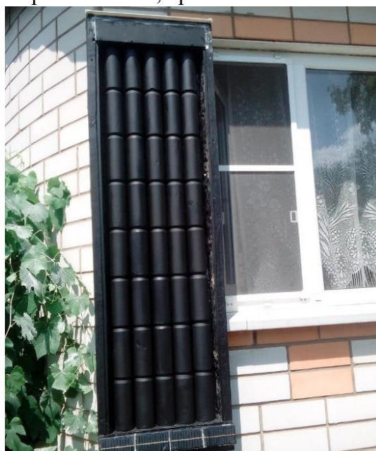
Obrázek 7: Vzduchový kolektor domácí výroby [20].
