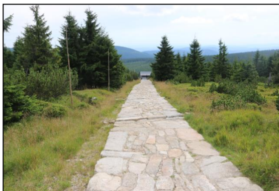
Obr. 17: První úsek zrekonstruované štětované cesty materiálem místního původu. Zdroj: fotografie Málková
