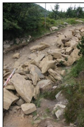
Obr. 20: rekonstrukce poškozeného úseku Zdroj: vlastní fotografie
