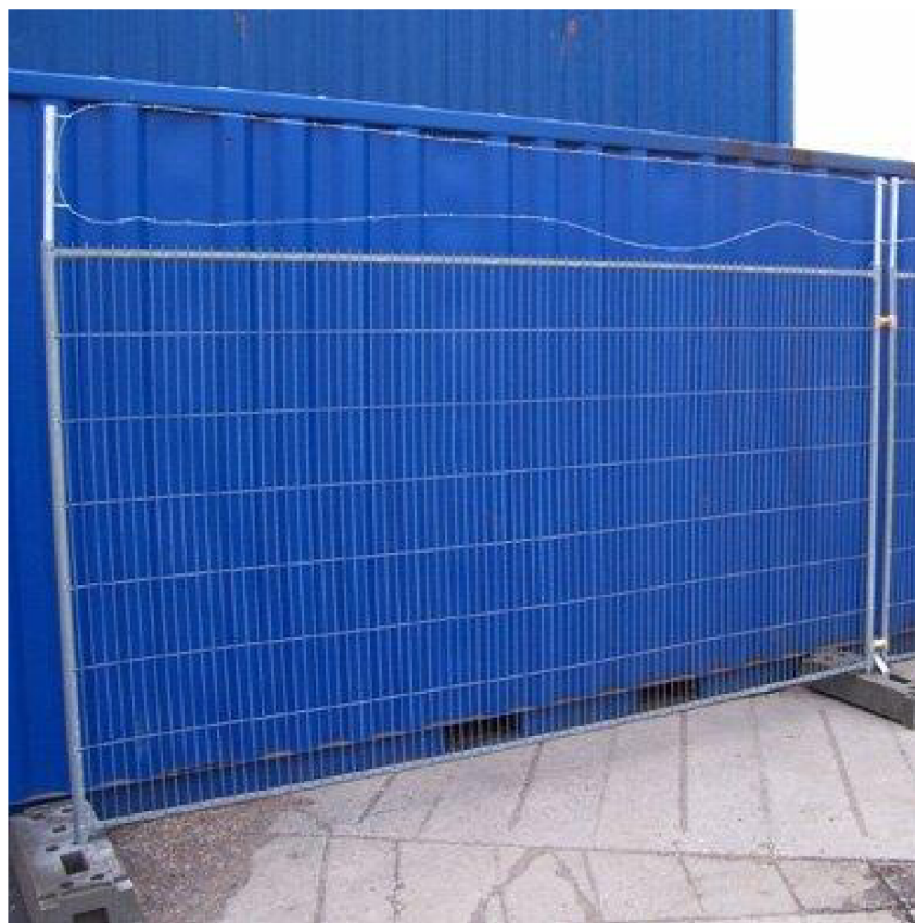
Obrázek 9.: Plotový dílec s betonovými patkami
