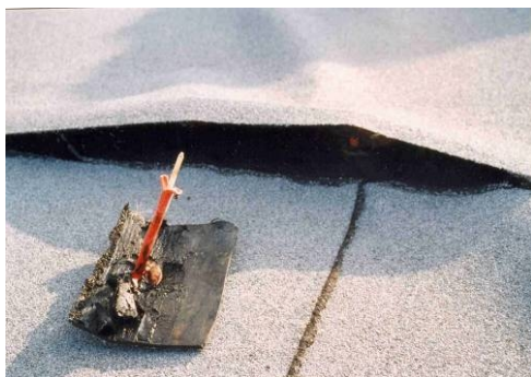
Obr. 3: Použití fasádních hmoždinek při kotvení hydroizolační vrstvy [84]
