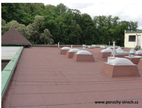
Obr. 1: První mechanicky kotvená střeška [85]
