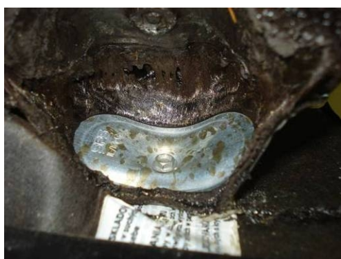
Obr. 101: Rozlepení spoje v okolí přítlačné podložky a počátek její deformace
