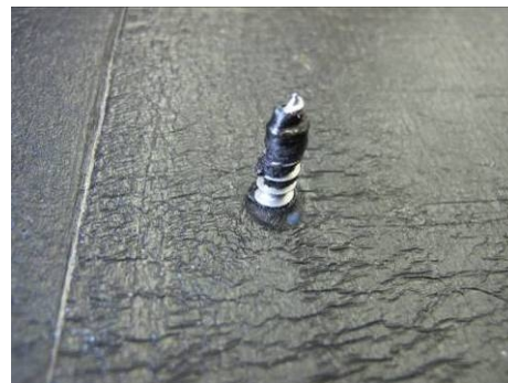
Obr. 41: Průnik kotevního prvku elastickým SBS modifikovaným pásem
