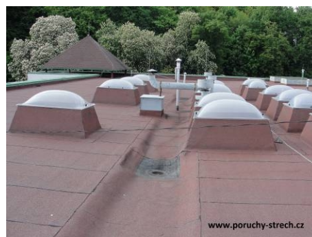
Obr. 2: První mechanicky kotvená střeška [85]
