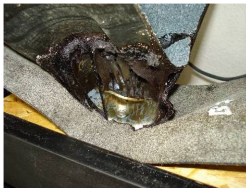
Obr. 89: Typické poškození spoje vzorku B
