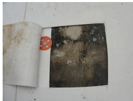
Obr. 4: Kotvení fasádními hmoždinkami, navíc nevhodně umístěnými
