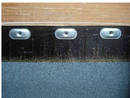
Obr. 48: Správné umístění kotevních prvků
