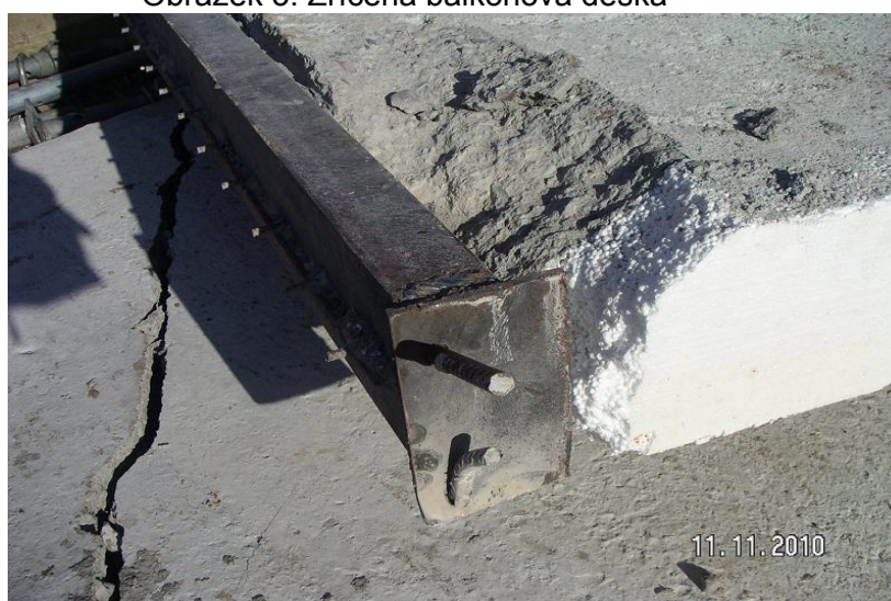
Obrázek 3: Zřícená balkonová deska
