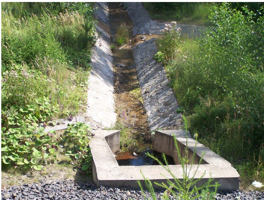
foto 11: Část Zlonického potoka protékajícího vybetonovaným korytem
