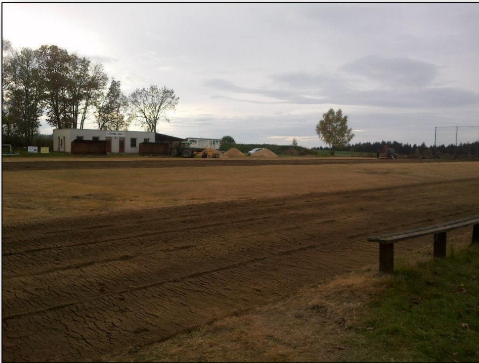
Foto 9 – Období rekonstrukce fotbalového trávníku.
