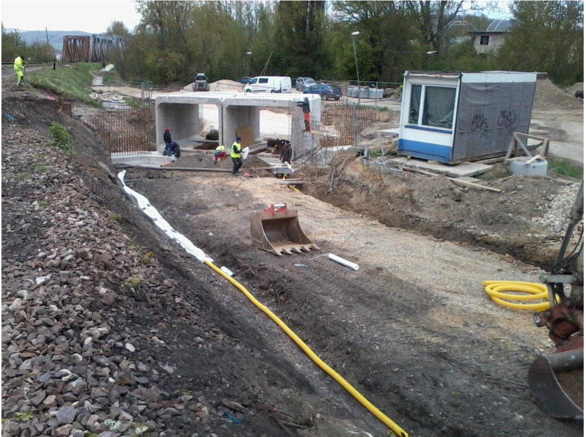
Obrázok 7-14: Drenáž na odvodnenie podchodu [autor]
