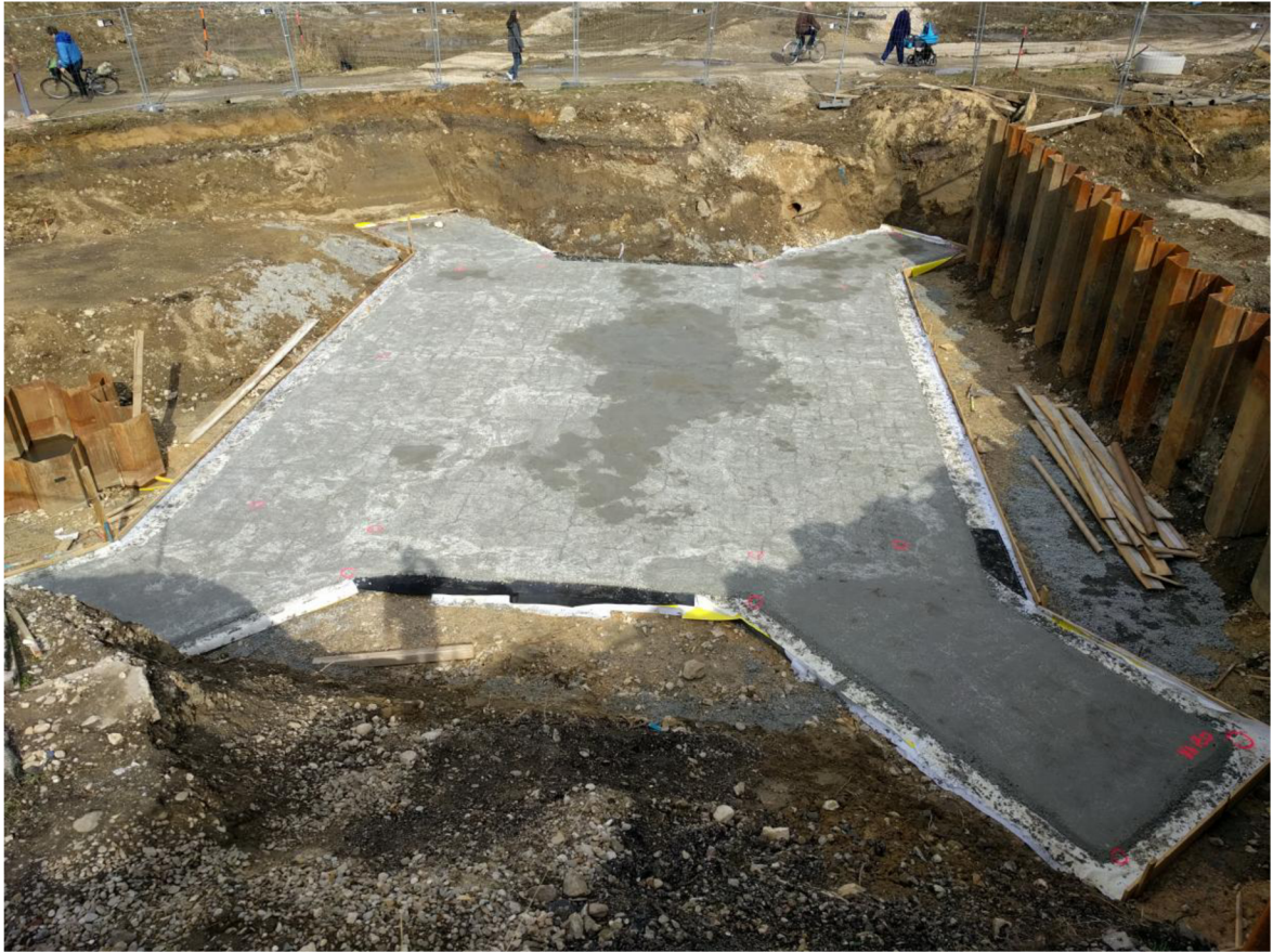
Obrázok 7-10: Podkladový betón s krytom izolácie [autor]
