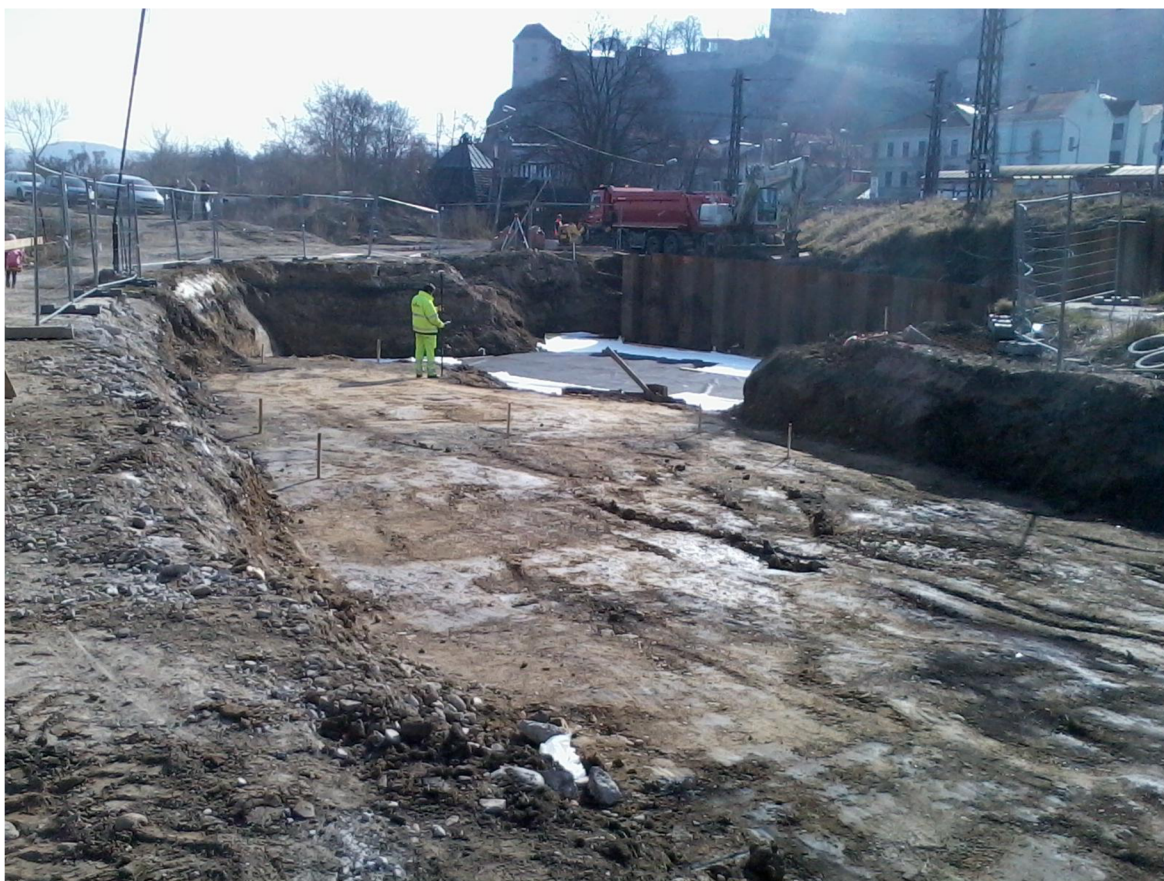
Obrázok 7-9: Výkop podchodu a komunikácie, smer Trenčín centrum [autor]
