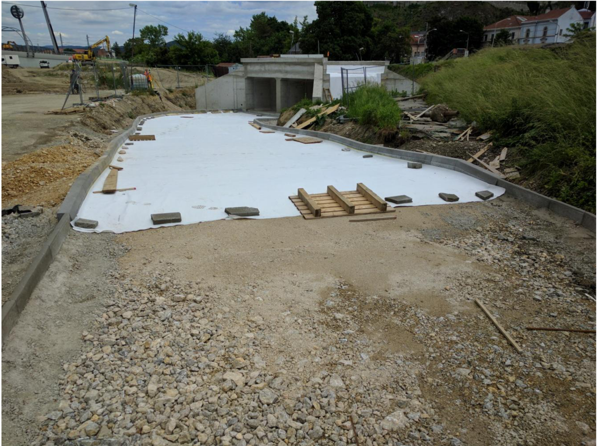
Obrázok 7-16: Osadené obrubníky komunikácie podchodu [autor]
