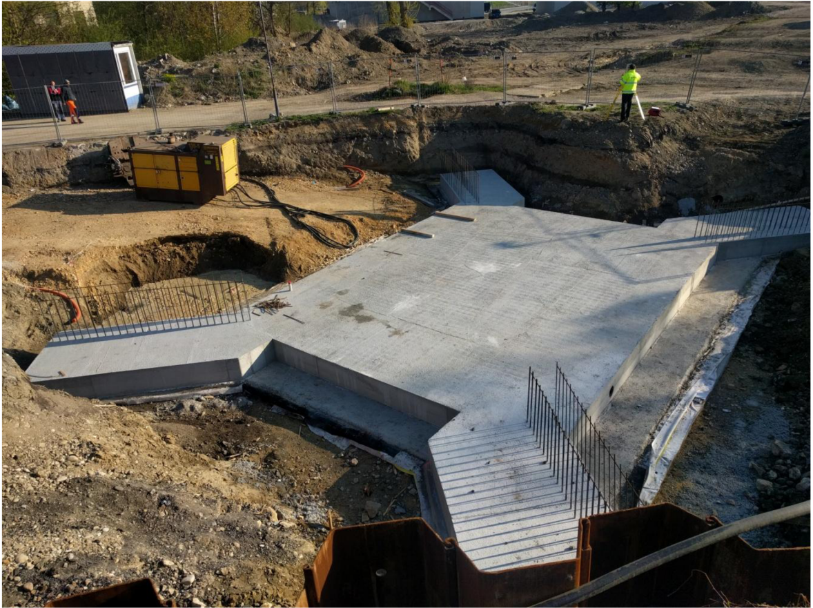
Obrázok 7-12: Základová doska podchodu [autor]
