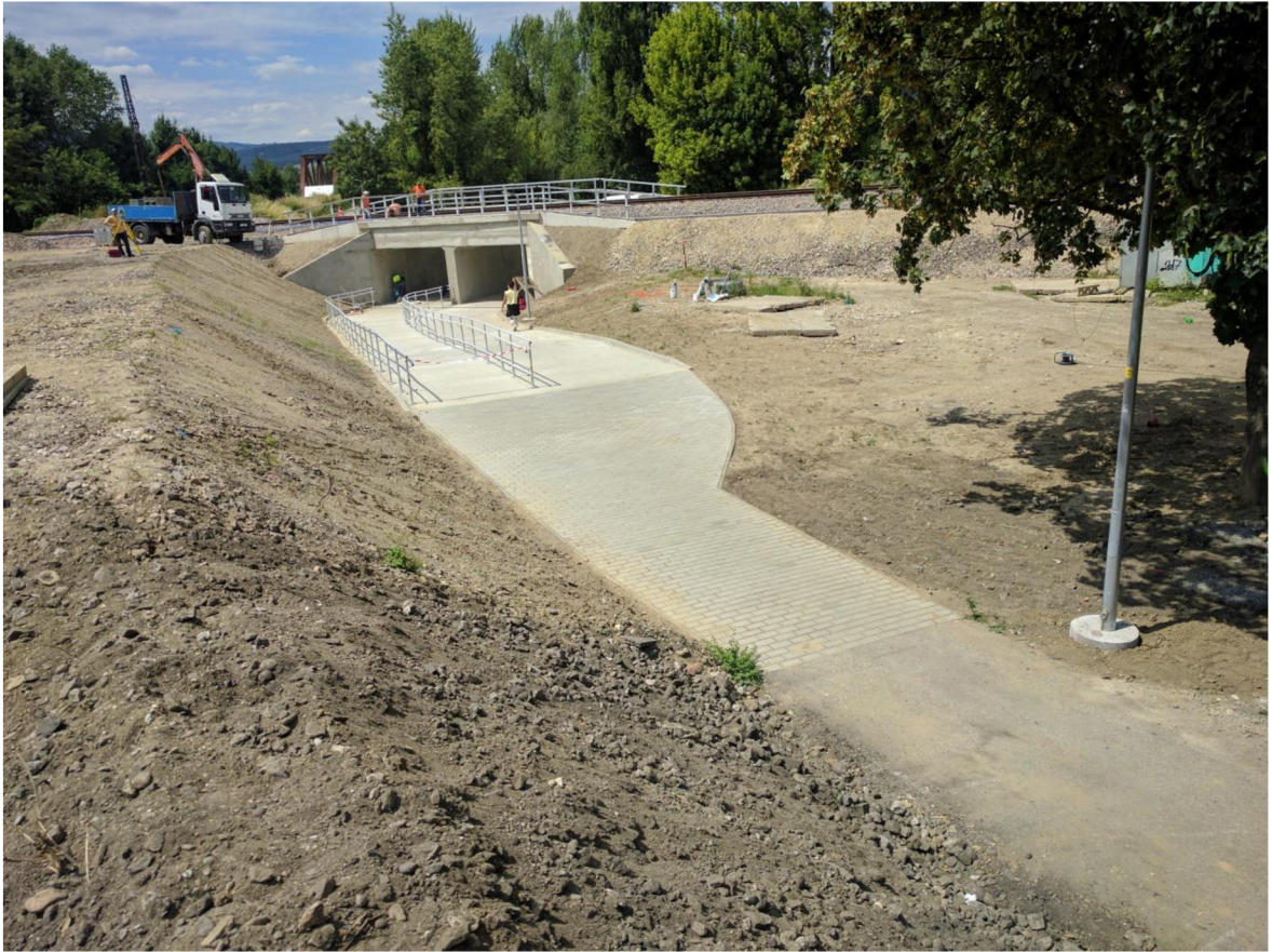
Obrázok 3-6: Pohľad na okolitú úpravu terénu a komunikáciu podchodu [autor]
