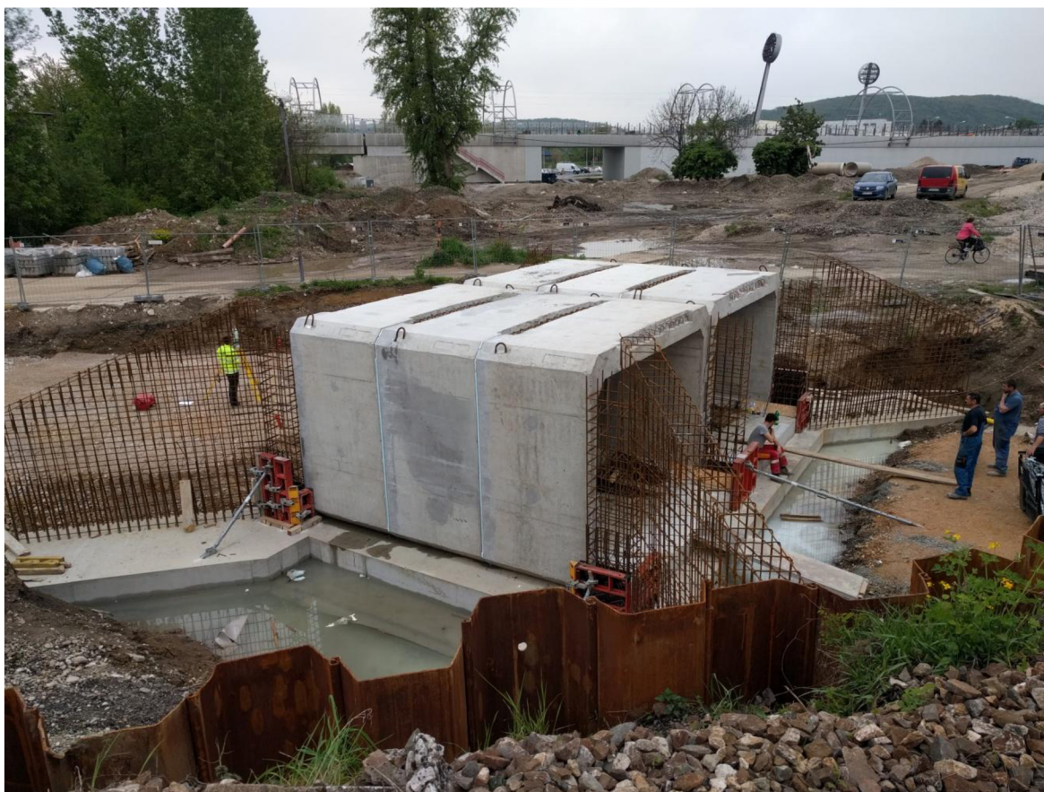
Obrázok 7-13: Osadené rámové prefabrikáty tubusov [autor]
