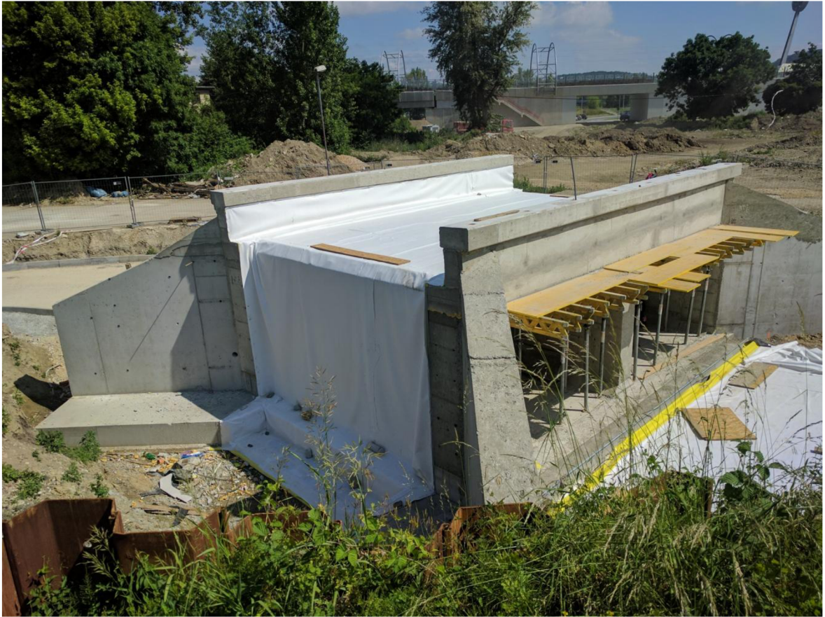
Obrázok 7-17: Podchod po betonáži dilatačných celkov [autor]
