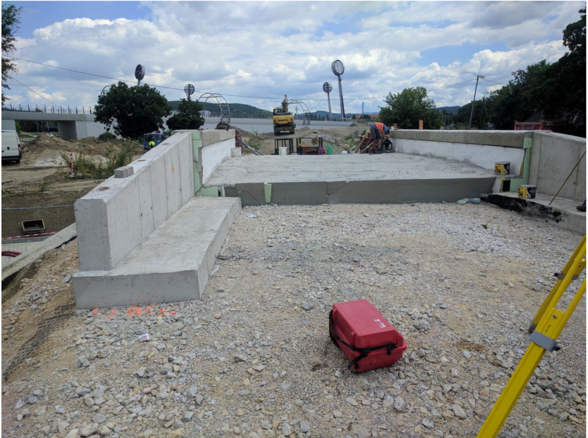
Obrázok 7-20: Rimsová stienka po realizácii [autor]
