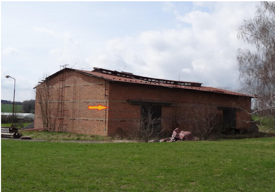
Obr. 4-12: Identický bod č. 124 – roh budovy
