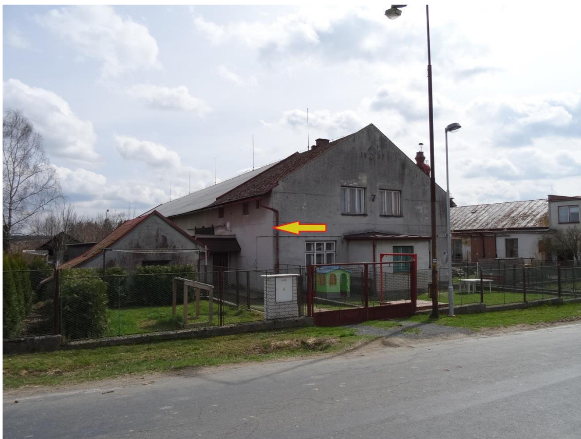
Obr. 4-6: Identický bod č. 212 – roh budovy
