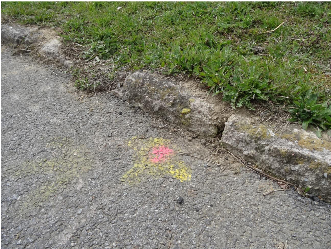
Obr. 2-3: Ukázka stabilizace pomocného měřického stanoviště č. 4001
