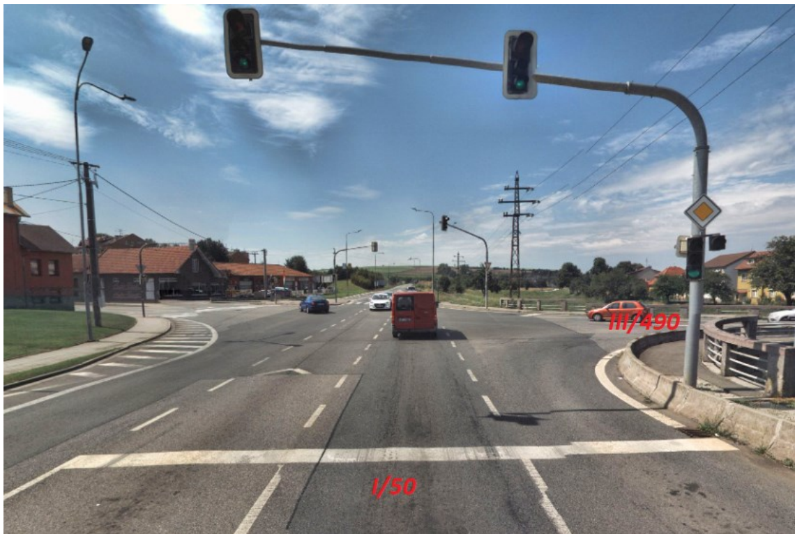
Obr. 3.5 Křížení silnic I/50 a III/490.
