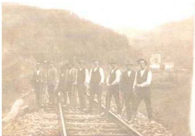
Obr. 1 Stavba železnice (Zdroj: Kronika obce Dzbel)
