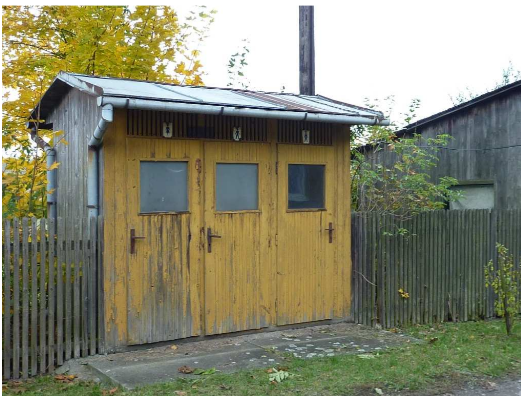
Obr. 4 Suché záchody u železniční stanice (Zdroj: autor práce)
