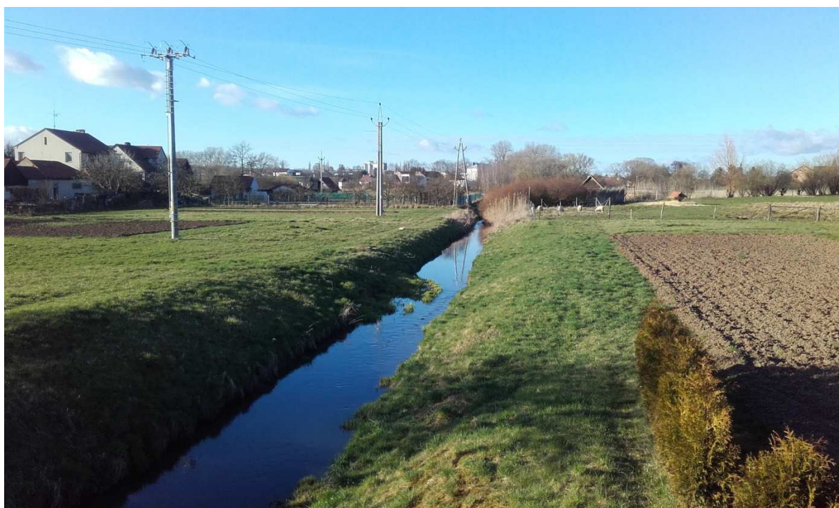
Obr.č.11 Odběrné místo č.4 (autor)
