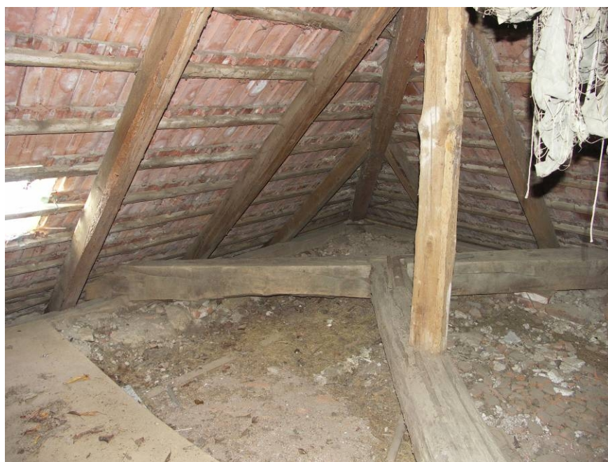
Obr. 3.5 Nárožní krokev a výměna
