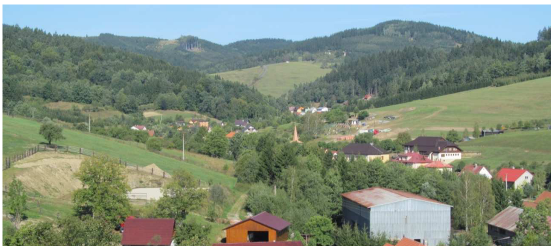
Obr. 2.5 Pohled na horní tlakové pásmo
