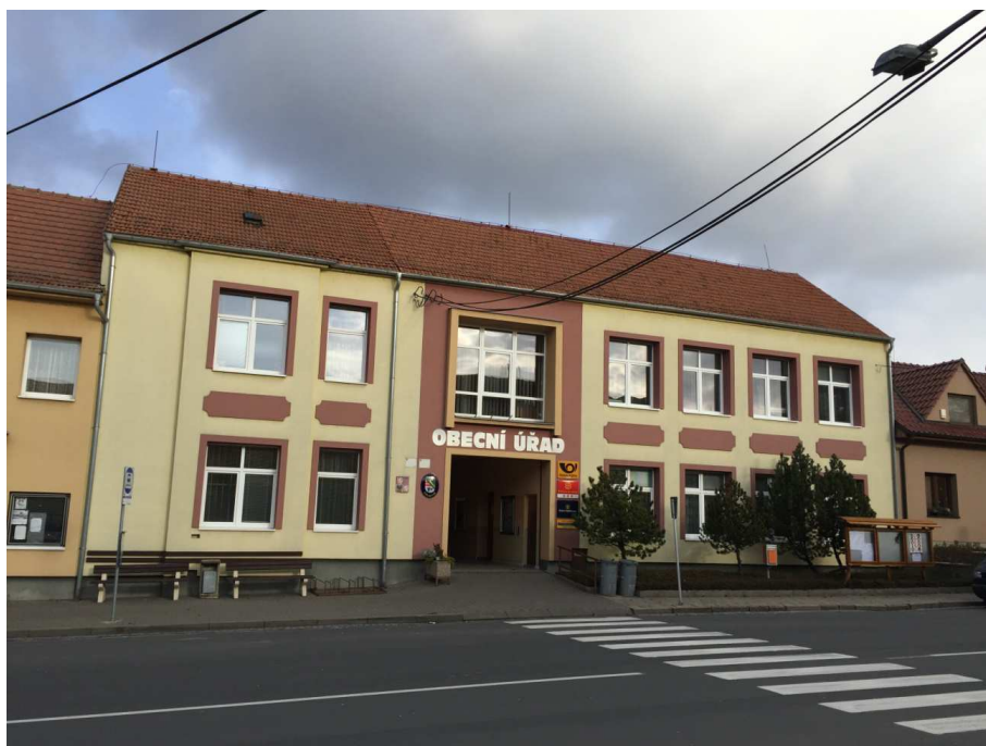
Příloha 3: Budova obecního úřadu v obci Krumvůř
