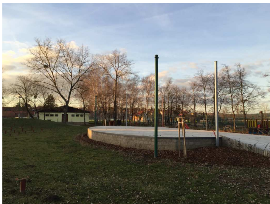
Příloha 10: Probíhající rekonstrukce národopisného stadionu
