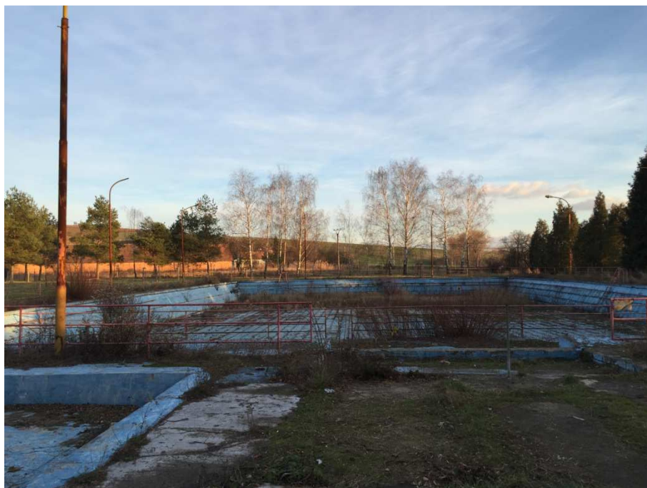
Příloha 9: Bývalé koupaliště
