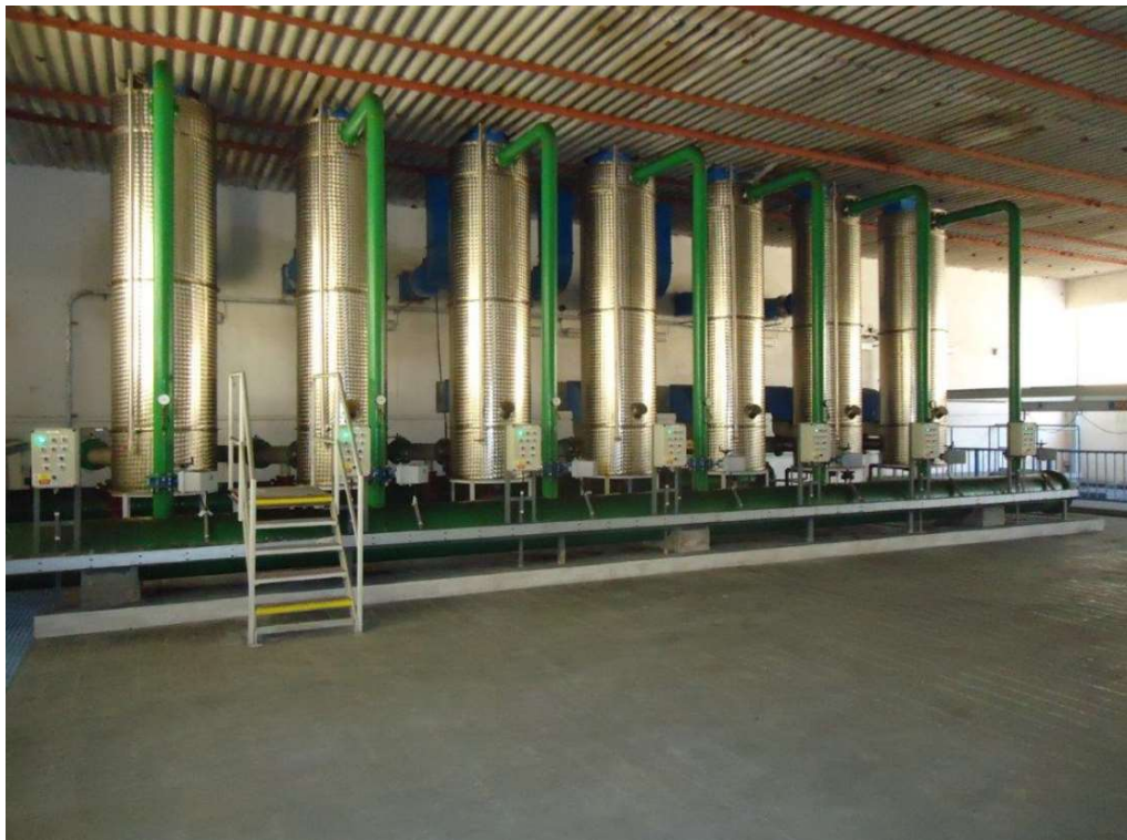
Obr. č. 10: Filtry s granulovaným aktivním uhlím v úpravně vody Klíčava (autor, 2020).
