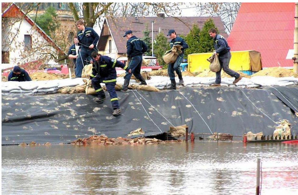
Obrázek 16: Stavba ochranné hráze v roce 2006 (Janovský V 2006)
