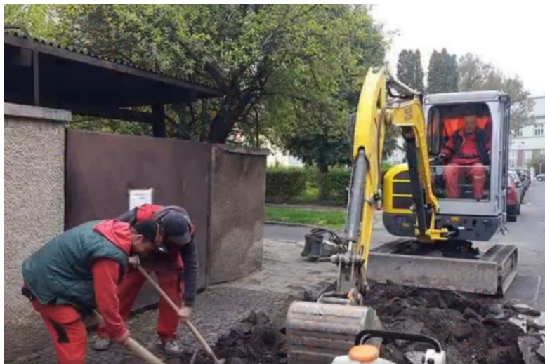
Obr. 7 Výkopové práce. Zdroj vlastní.
