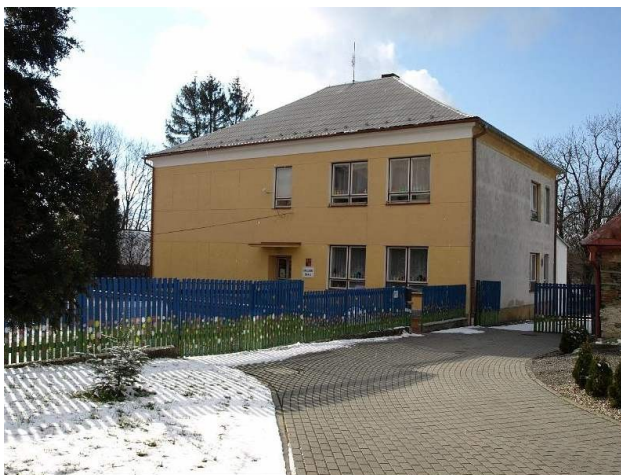
Obr. č. 1: Budova školy ZŠ Jívová
